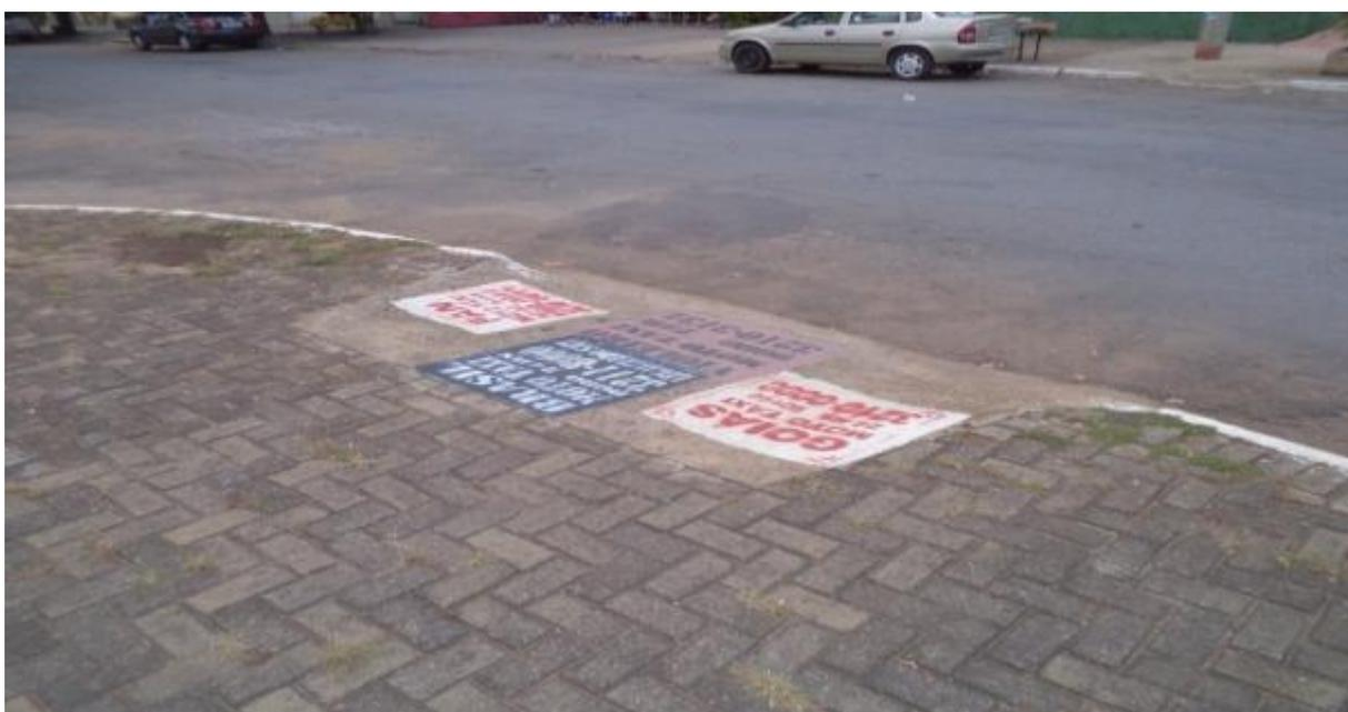
Figura 11: Rampa com rebaixamento de calçada.
