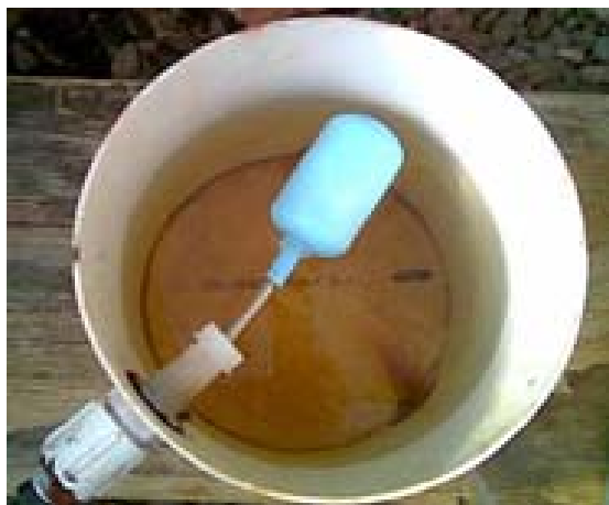
Figura 3. Bóia para filtro mantendo o nível de água a 15 cm no reservatório (R2) e no “vaso”.
