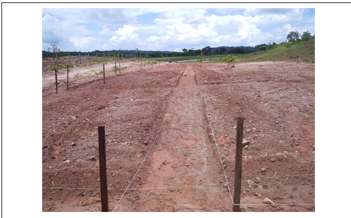
Figura 1. Característica da área degradada e demarcação das parcelas dos tratamentos com adubo mineral e doses crescentes de lodo de esgoto, à margem da Rodovia BR 060, km 124. Goianápolis, GO. Dezembro/2004.
