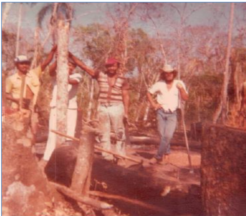
Figura 21: Trabalhadores na construção da primeira casa para os Avá-Canoeiro do rio Tocantins
