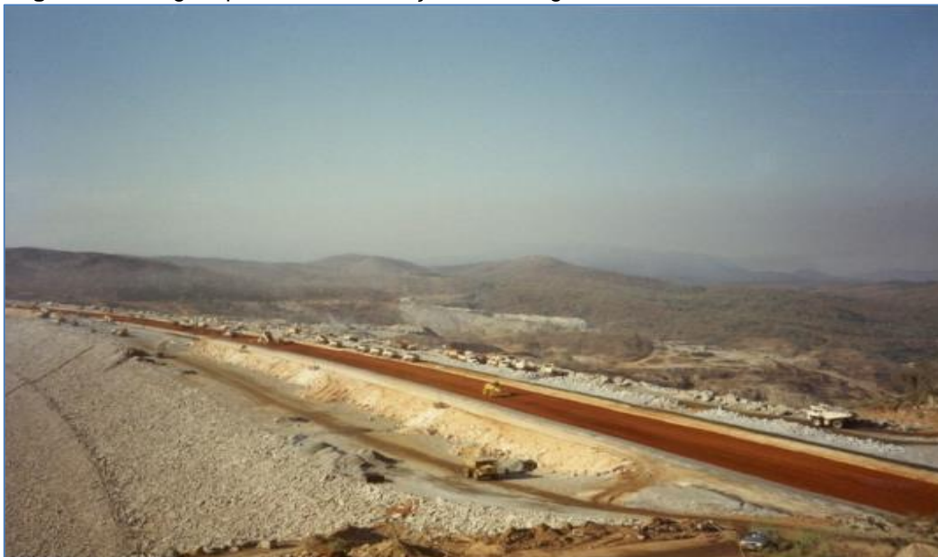
Figura 27: Imagem parcial da construção da barragem da UHSM/Goiás
