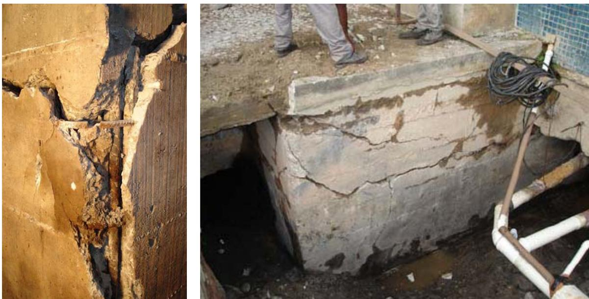
Figura 1.1 – Fissuras causadas pela RAA em edifício público de 13 pavimentos, construído em 1994 com agregado milonítico contendo quartzo deformado, microcristalino e recristalizado (ANDRADE *et al.*, 2006b).
