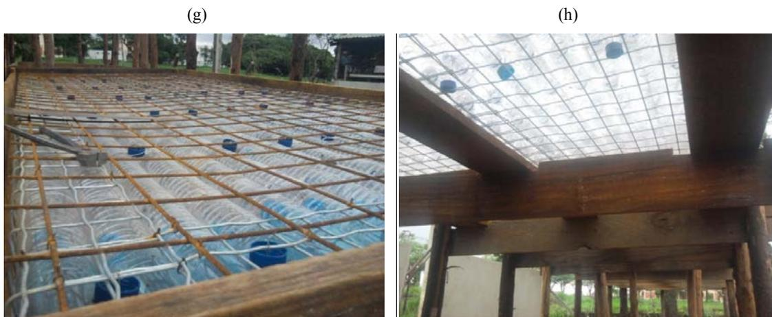
Figura 4.20i e 4.20j - Painéis de laje finalizados e o içamento dos painéis para serem transportados para o laboratório LABITECC
