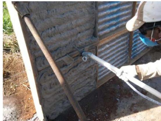
Figura 4.18c - Projeção da argamassa produzida em obra por meio do maquinário método canequinha
