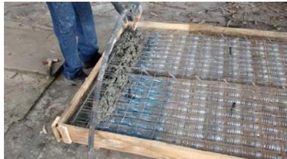
Figura 4.27c e 4.27d - Os pré-painéis de lajes sendo revestidos com argamassa (face inferior da laje)
