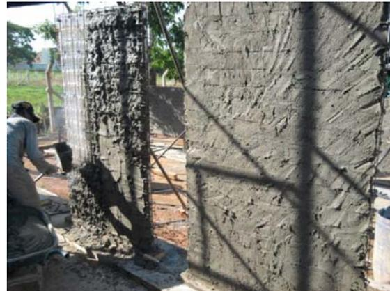
Figura 4.20c e 4.20d - Painéis de parede sendo preparados para ensaio (tela eletrossoldada galvanizada malha 5 cm x 5 cm  $\varnothing$  2,76 mm, argamassa industrializada, projeção método bomba)
