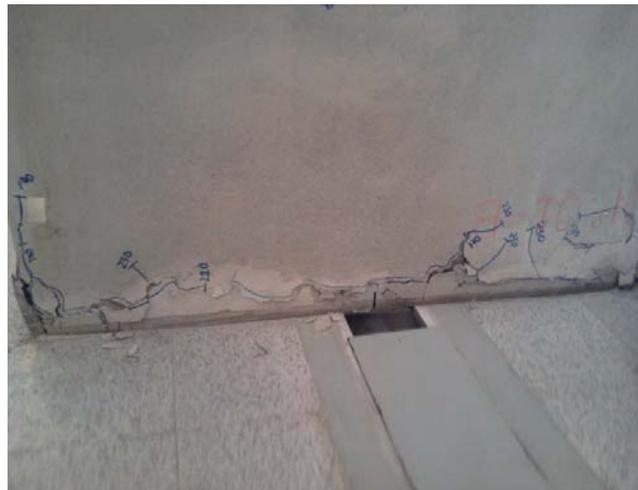
Portanto, é de suma importância que haja na parte superior das paredes uma cinta de concreto que englobe sua armação. E na parte inferior das paredes, ligando a tela à base de sustentação, uma ferragem de arranque ou de transição de esforços, melhorando a transferência de carga para o suporte e aliviando a pressão na base das paredes.
