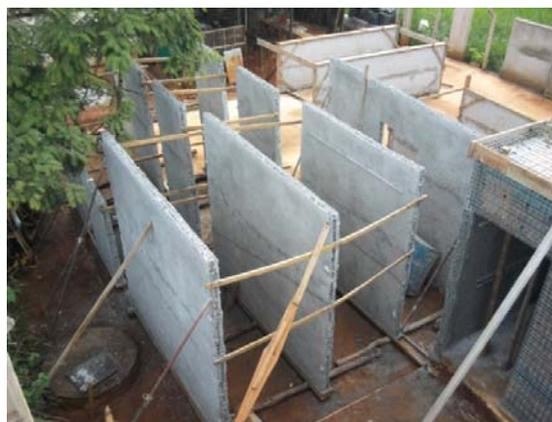
Figura 4.22e e 4.22f - Os painéis de laje para ensaios do IPT sendo revestidos
