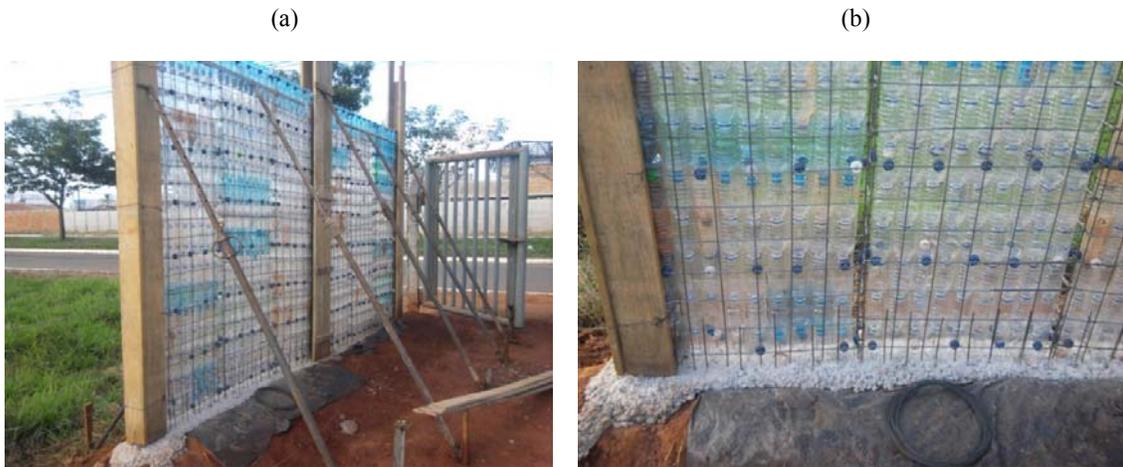
Figura 4.17c e 4.17d - Painéis para ensaio de muro sendo argamassados (primeira camada) executados com canequinha a ar comprimido e traço produzido em obra
