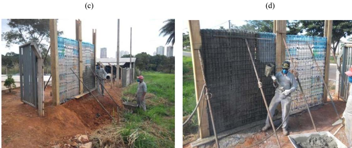
Nos três processos de projeção da argamassa sobre os painéis, o comportamento foi semelhante, isto é, não houve desprendimento e queda da argamassa dos painéis e a finalização do revestimento estruturante (argamassa armada) ocorreu satisfatoriamente.
