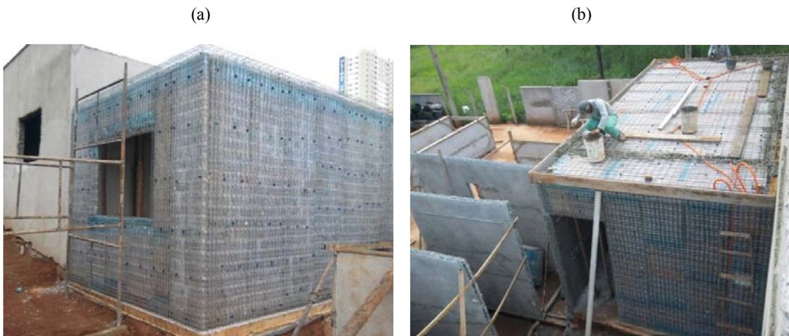
Figura 4.21c e 4.21d - A primeira camada de revestimento estrutural aplicada na obra piloto e a segunda camada já finalizada
