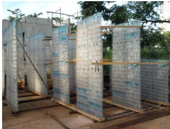
Figura 4.22c e 4.22d - Os painéis de parede para ensaios do IPT sendo revestidos
