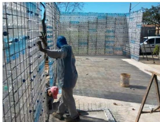
Figura 4.19c e 4.19d - Painéis PET posicionados da primeira obra piloto
