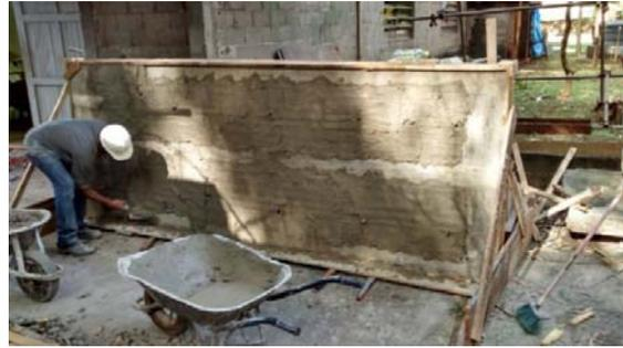
Figura 4.27e e 4.27f - Os pré-painéis de parede sendo revestido para o ensaio de estanqueidade à água de paredes e choque térmico
