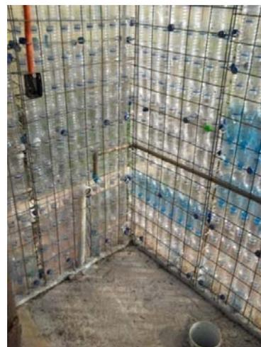
Figura 4.19g e 4.19h - A obra piloto depois da aplicação da primeira camada de argamassa estruturante
