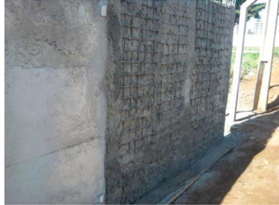
Neste ensaio, constatou-se que era melhor projetar a primeira camada e depois concretar os pilares, pois se consegue uma maior vedação das laterais das formas para que a argamassa do concreto não escoe e por consequência surjam brocas neles. Verificou-se, também, que a projeção da argamassa tinha o mesmo comportamento da argamassa quando lançada manualmente, mas com ganhos em produtividade de mão de obra, ou seja, mais área executada de lançamento de argamassa em menos tempo.
