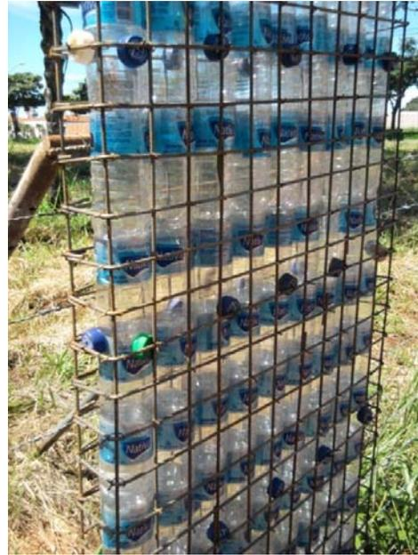
Figura 4.15c e 4.15d - Painel parede isolada tipo muro sendo argamassado e já finalizado
