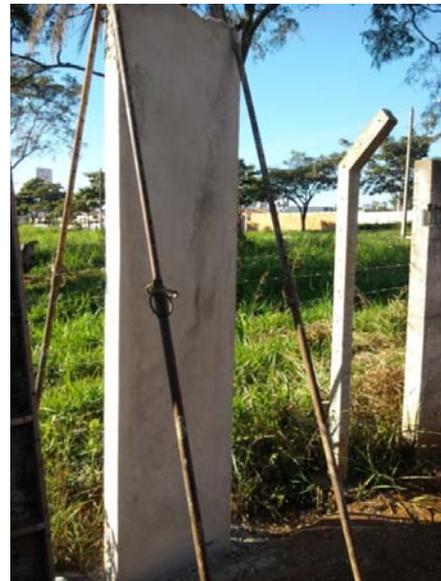
A argamassa durante o processo de lançamento manual (chapar) não se desprendia, pois a tela oferecia suporte para que ela permanecesse no local. A estabilidade do painel antes da moldagem da argamassa foi satisfatório para permitir o trabalho de aprumação do painel PET, utilizando-se dos aprumadores metálicos.
