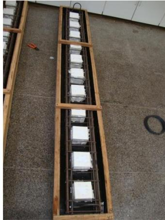
c) Concretagem da viga pré-moldada.
