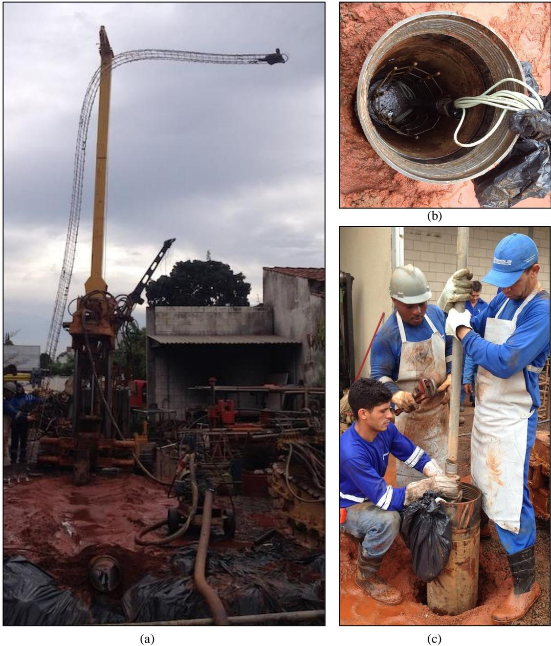
A primeira leitura dos sensores foi realizada 3 dias após a concretagem (Figura 5.28d), e apenas 1 (um) dos 8 (oito) sensores foi perdido, sendo o sensor de imersão do nível de 9 metros. Existem duas hipóteses para justificar perda deste sensor: i) ao içar a armadura a flexão da mesma causou ruptura do cabo, ou avaria que provocasse curto no cabo; e ii) a inserção do tubo galvanizado de 50 mm durante a concretagem, ao subir ou descer, pode ter causado avaria no cabo do sensor a 9 metros.
