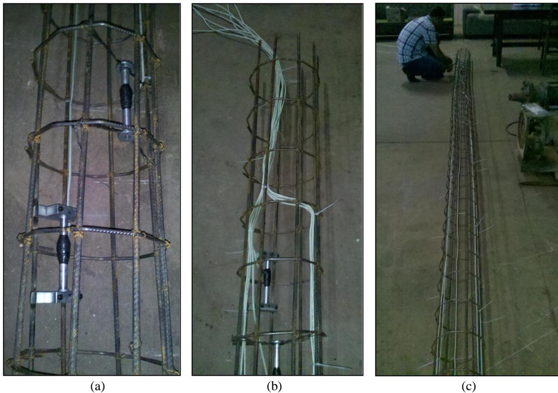
Os cabos dos sensores foram amarrados ao longo das barras longitudinais com presilhas plásticas, de modo a deixar todos os cabos o mais organizado possível para evitar danos da descida da ferragem e concretagem da estaca raiz.
