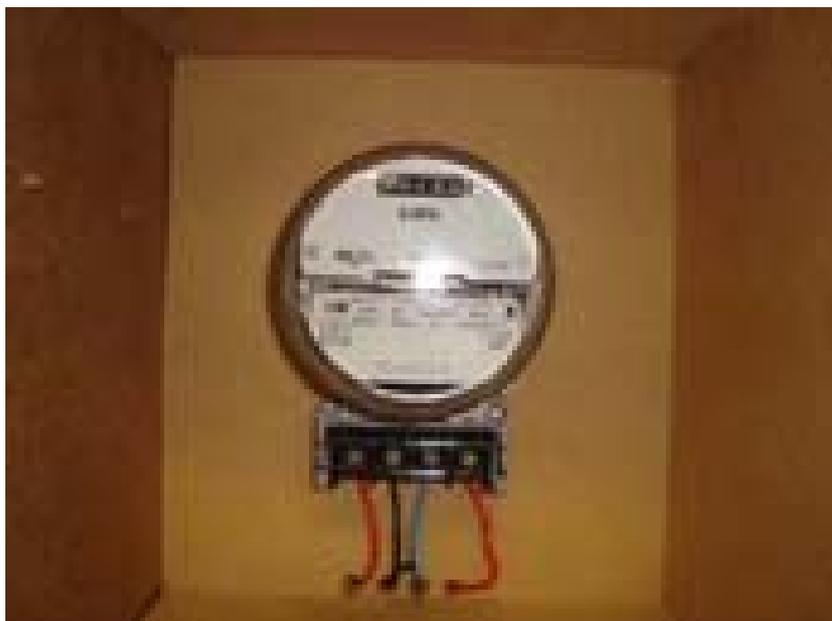
Fig. B-5 – Medidor monofásico do tipo eletromecânico.
