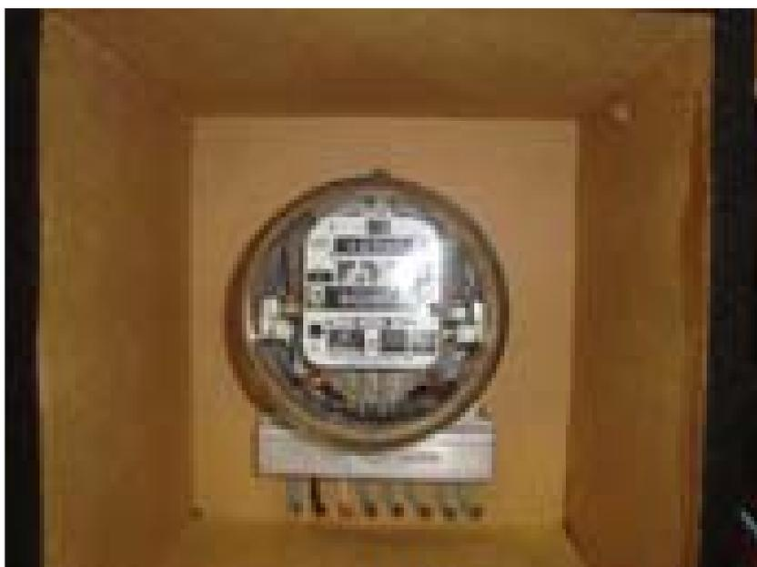
Fig. B-6 – Medidor trifásico do tipo eletromecânico.
