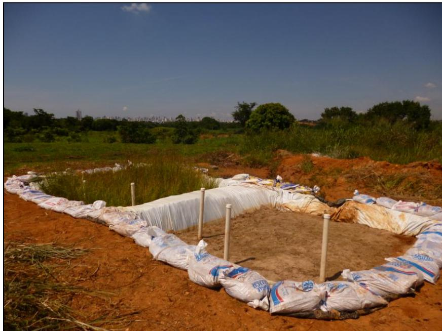
**Figura 17** Barreira de sacos com terra destinados à contenção das águas de escoamento superficial do terreno externo.
