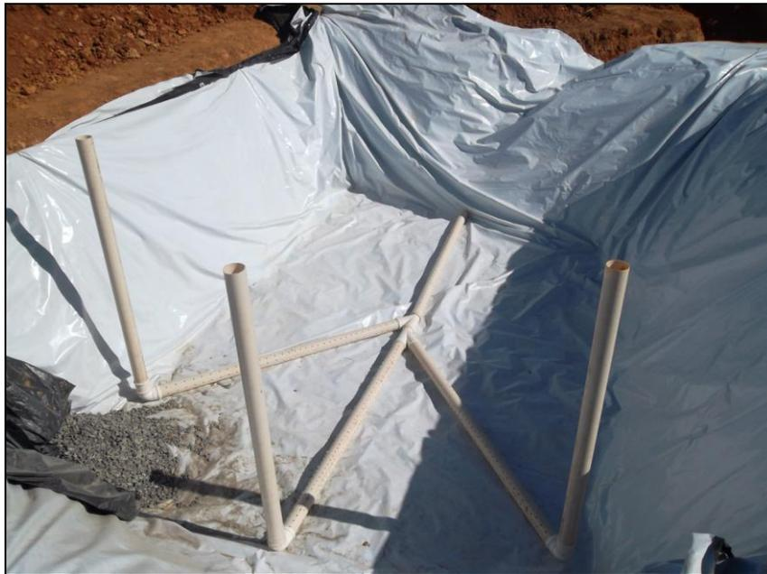
**Figura 14** Imagem parcial do sistema de impermeabilização dos tanques e do sistema de drenagem de gases e lixiviado.
