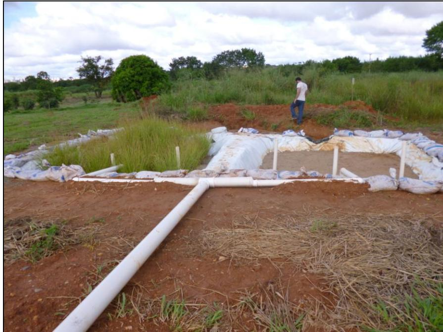
**Figura 18** Imagem geral do sistema de distribuição dos resíduos em ambos os tanques.
