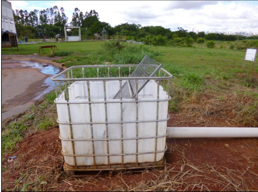
**Figura 19** Imagem da caixa receptora dos RFTS e da grade para retenção dos sólidos grosseiros.
