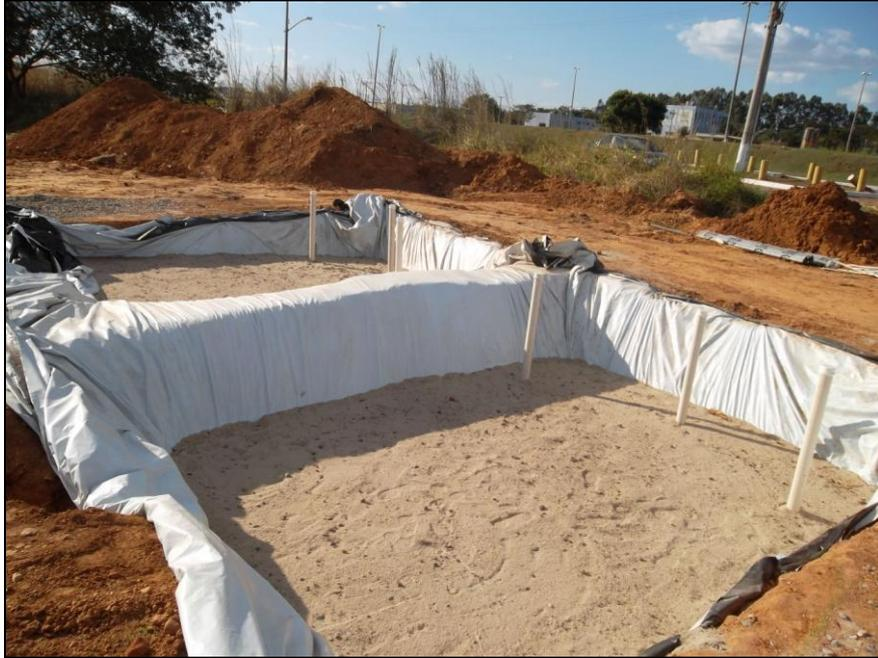
**Figura 16** Vista geral do sistema após o preenchimento com substrato.
