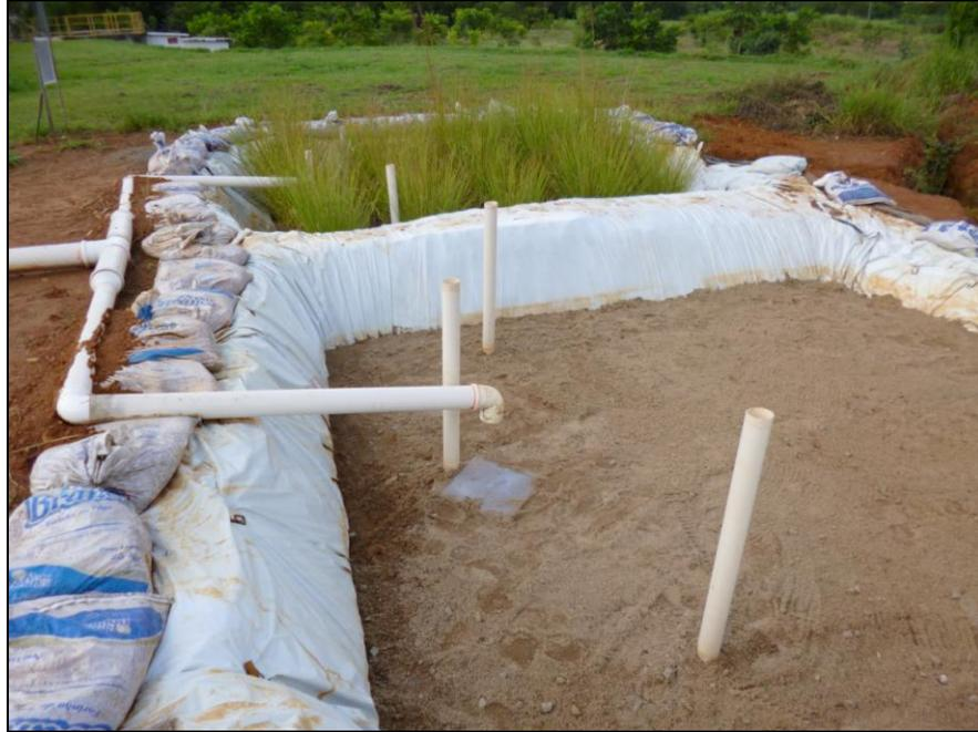
**Figura 11** Vista geral da estação experimental de tratamento de resíduos de fossas e tanques sépticos do tipo alagados construídos.
