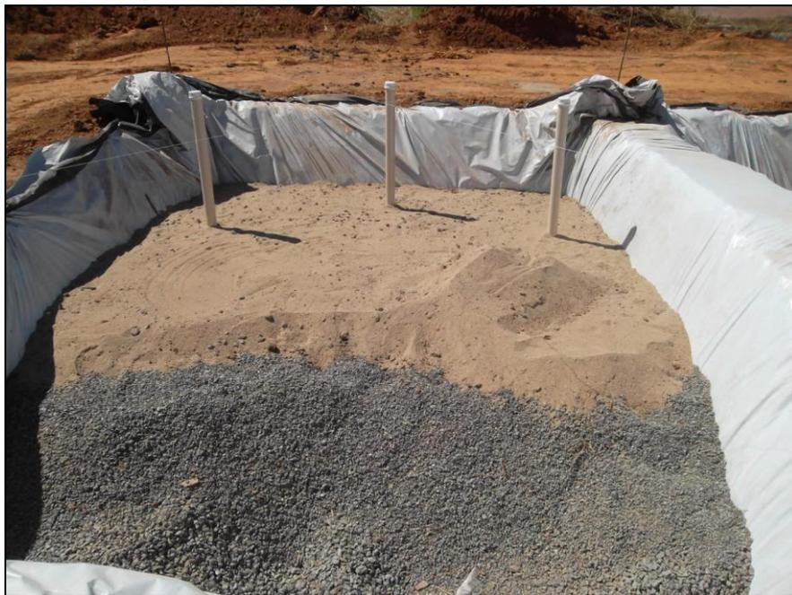
**Figura 15** Preenchimento do tanque com camadas superpostas de substrato.
