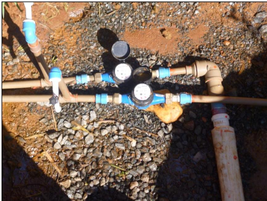
**Figura 23** Hidrômetros implantados nas descargas de fundo dos tanques para aferir os volumes drenados.
