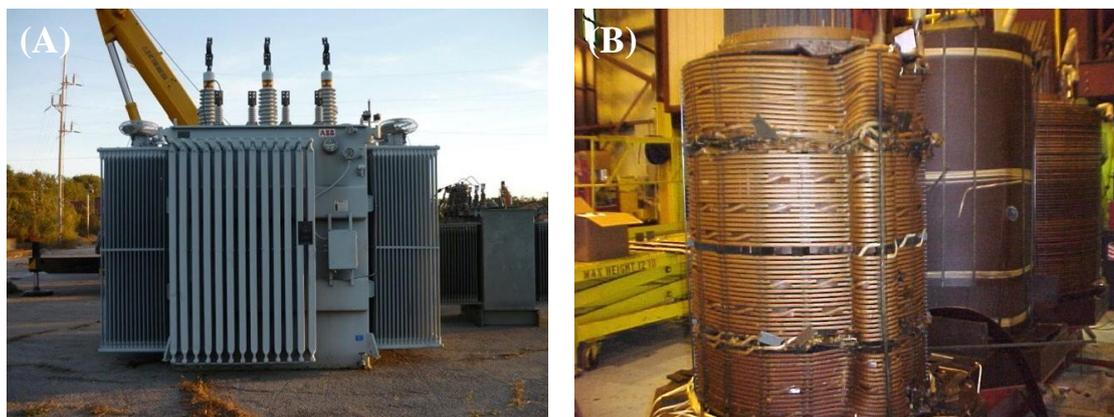
**Figura 1.** Transformador de potência: parte externa (A); parte interna (B) [9,10].
