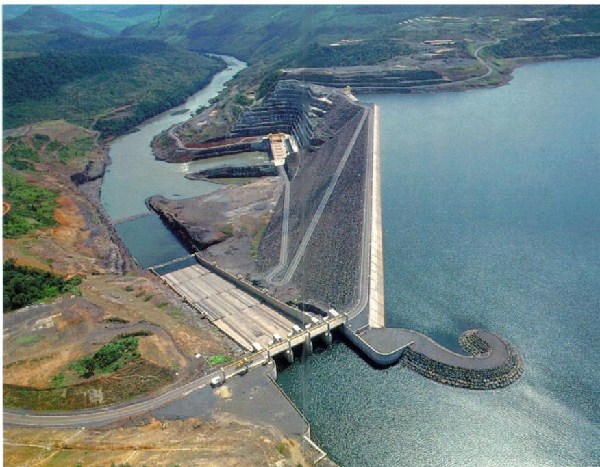
Figura 2. 1 – Barragem Foz do Areia em enrocamento com face de concreto (CRUZ, 2004)
