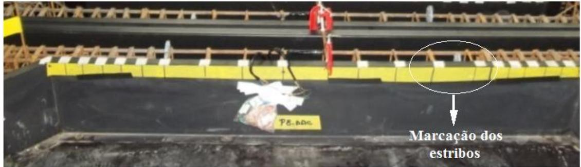
Figura 3.13- Marcação da posição dos estribos
