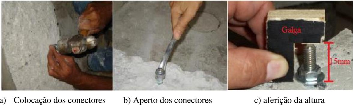
Figura 3.21- Fixação dos conectores
