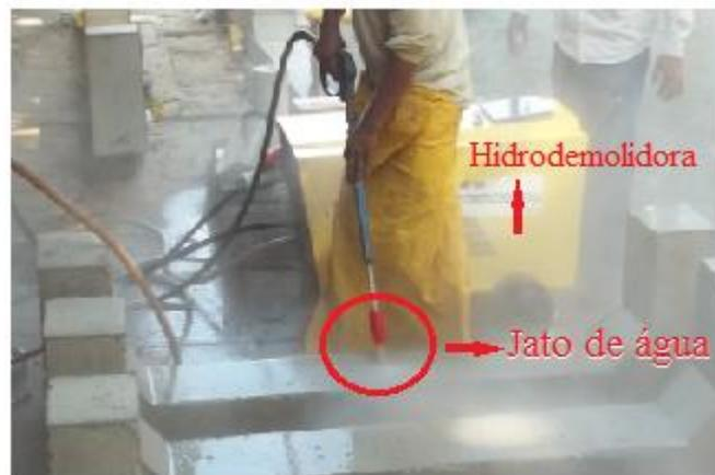
Figura 3.18- Escarificação do substrato utilizando água sob pressão
