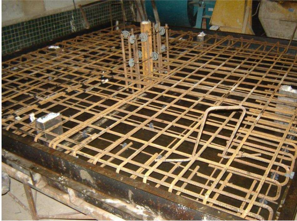
Figura 3.18 – Fotografia da laje L1 pronta para moldagem
