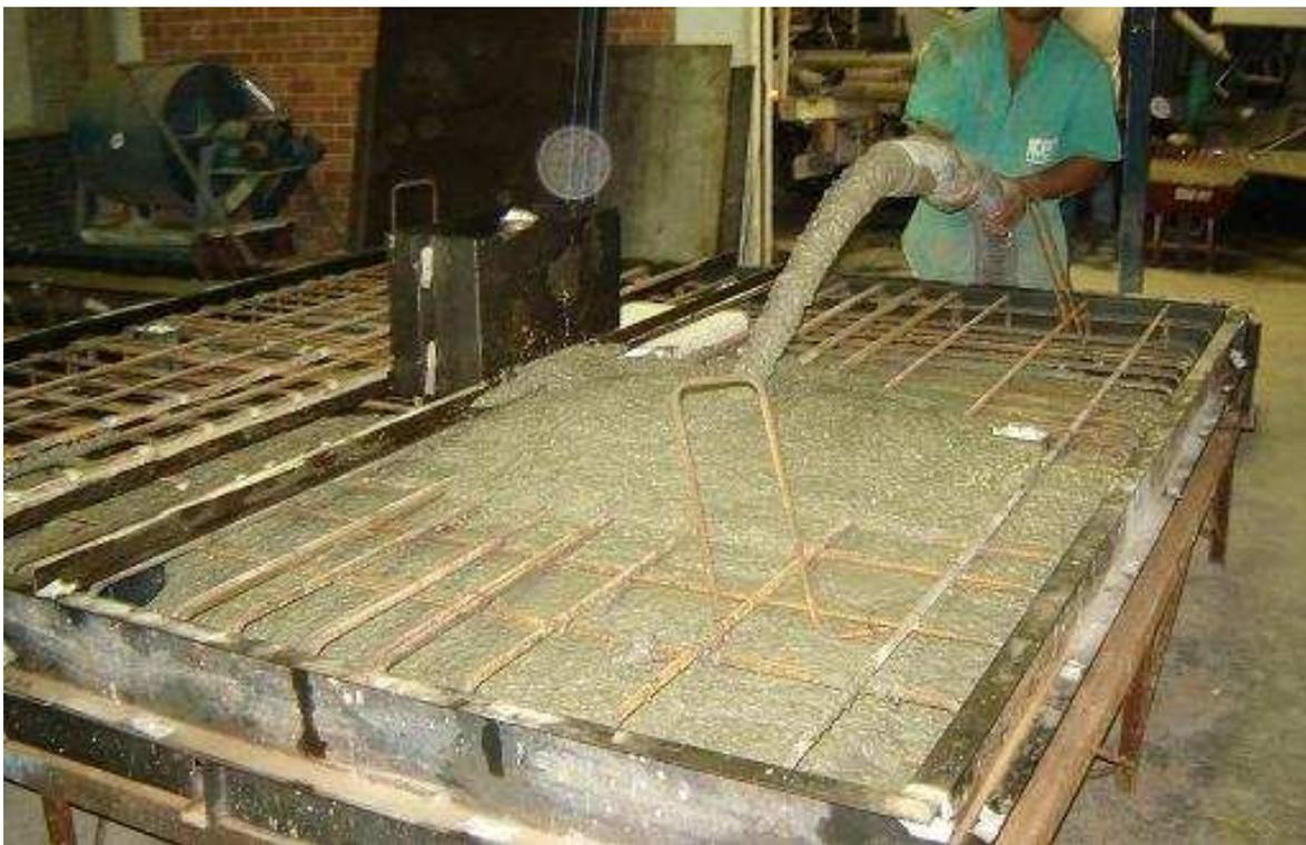
Figura C.3 – Concretagem (concreto auto-adensável)
