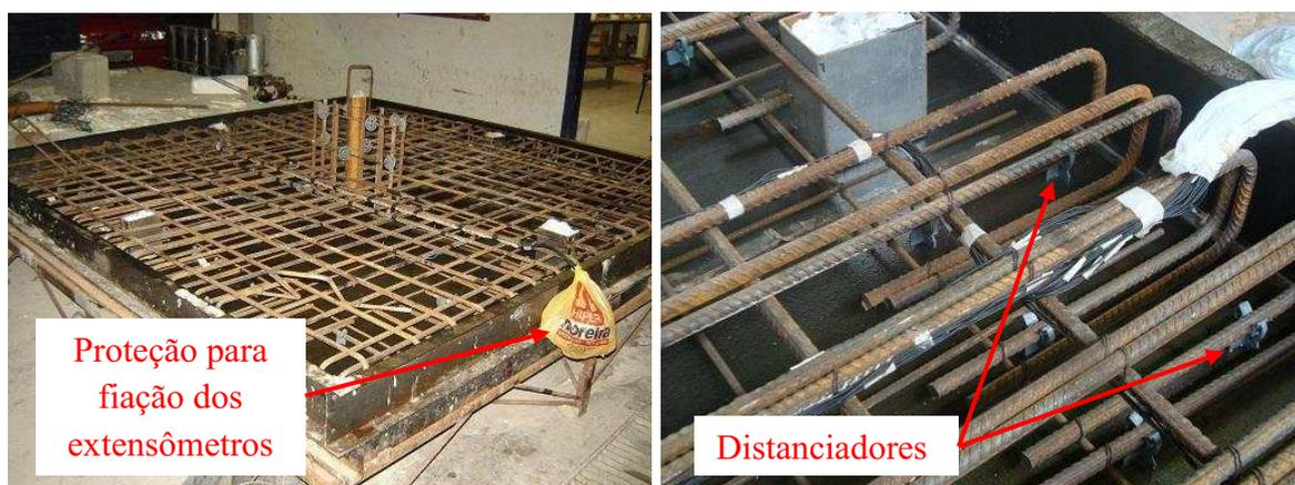
Figura C.2 – Preparativos para a concretagem
