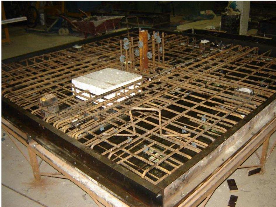
Figura 3.20 – Fotografia da laje L3 pronta para moldagem
