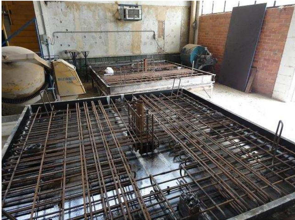
Figura 3.22 – Fotografia das lajes L5 e L6 prontas para moldagem
