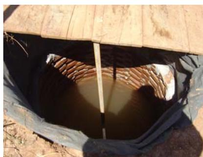
Figura 4.10 – Poço 2: vista do revestido do poço com tijolo em crivo e da manta de geotêxtil na interface solo-revestimento.
