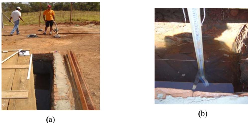
Figura 4.11 – Vala de infiltração: a) acabamento da boca em tijolo maciço argamassado e a configuração final da vala; e b) processo de monitoramento no dia do ensaio.
