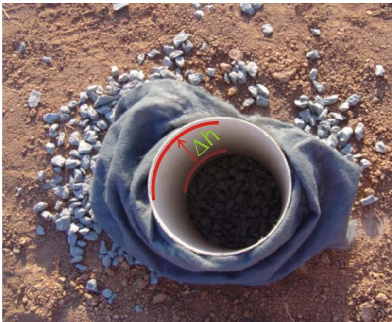
Figura 5.45 – Detalhe do acabamento da boca das estacas com a referência para a medida do  $\Delta h$ .
