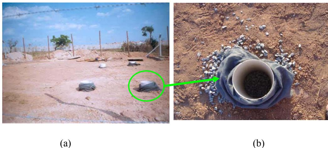
Figura 4.8 – a) Estacas a trado: a) vista geral da locação das quatro estacas instaladas no campo; e b) detalhes do acabamento da boca das estacas.
