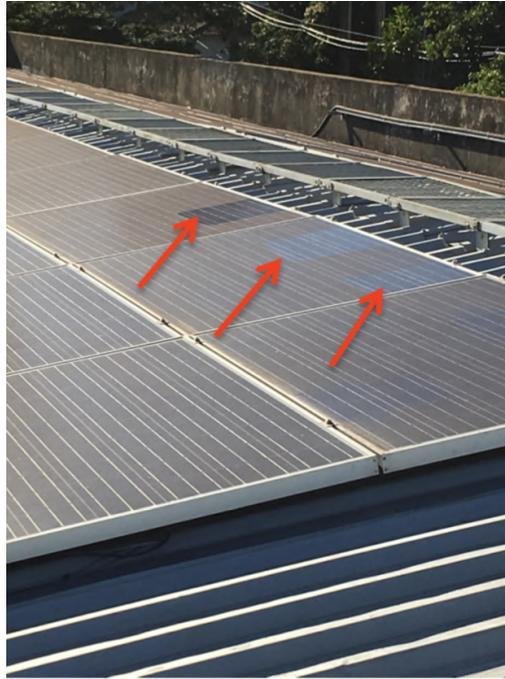
Figura 23: Poluição da superfície dos módulos do SFV da EMC/UFG.
