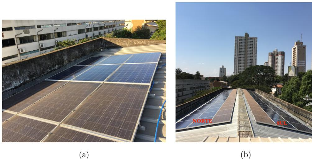
Figura 42: Contraste entre módulos limpos e módulos sujos durante a limpeza. (a) Primeira limpeza realizada. (b) Limpeza dos módulos selecionados, apenas.
