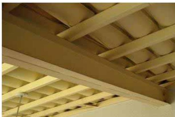
Figura 2.8 – Viga com seção tipo “I” formada pela união de perfis do tipo U simples
