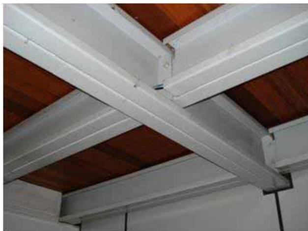
Figura 2.9 – Viga com seção tipo “I” formada pela união de perfis do tipo U enrijecido
