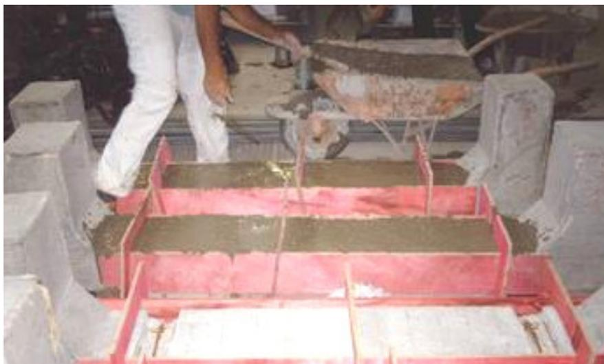
Figura 3.16 – Concretagem do reforço com CAA
