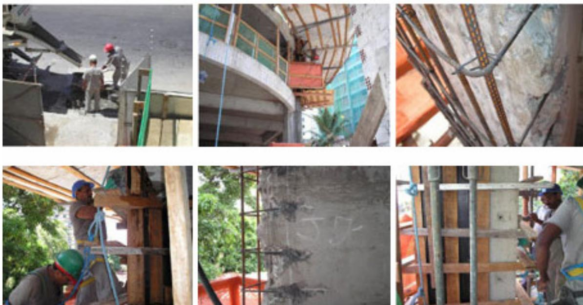
Figura 2.11 – Reforço com aumento de seção de um pilar ([www.concrefix.com.br](http://www.concrefix.com.br))
