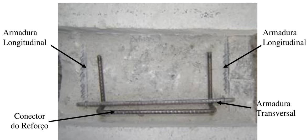
Figura 3.14 – Colocação dos conectores do reforço
