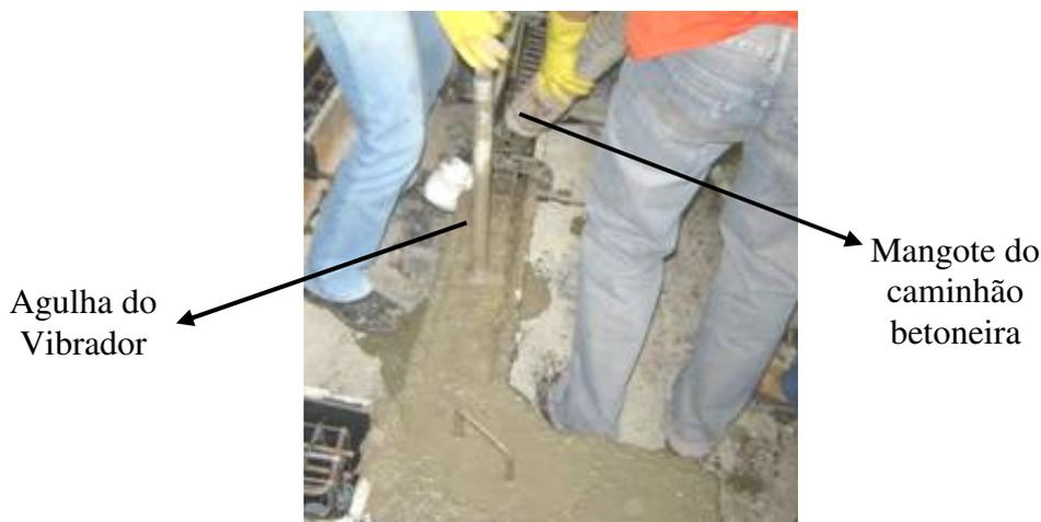
Figura 3.10 – Concretagem e adensamento dos pilares
