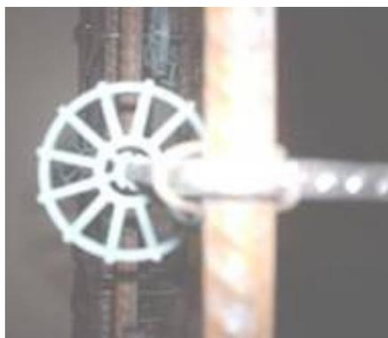
Figura 3.8 – Espaçadores utilizados nas armaduras
