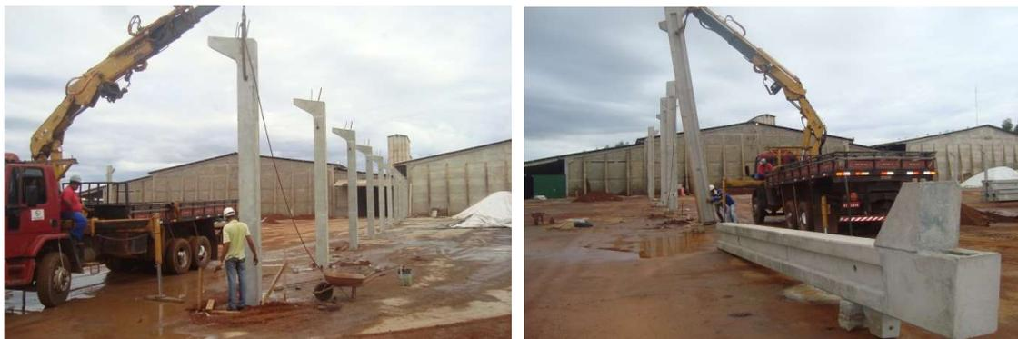
Figura 5.19 – Montagem das vigas da cobertura (obra C)
