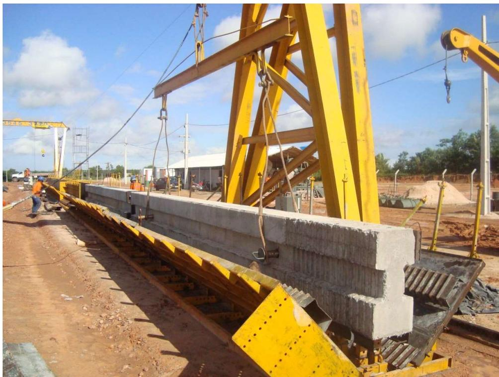
Figura 4.2. – Fase da obra do caso A: montagem dos pilares
