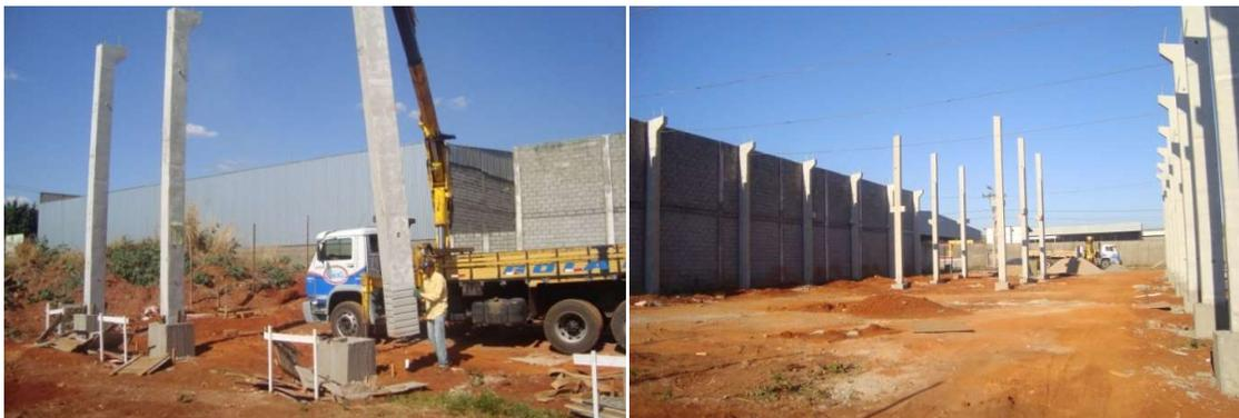
Figura 5.15 - Montagem das vigas do pórtico (cobertura)
