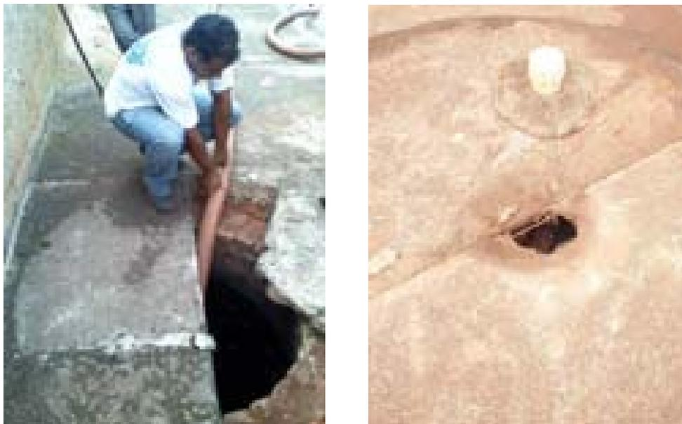
**Figura 12 – Exemplos de inadequação ou ausência dos dispositivos de inspeção das fossas**
