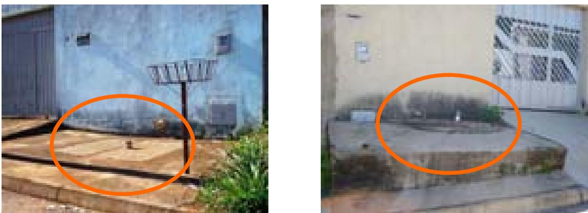
**Figura 10 – Exemplos de sistemas individuais de tratamento de esgoto localizados nas calçadas**
