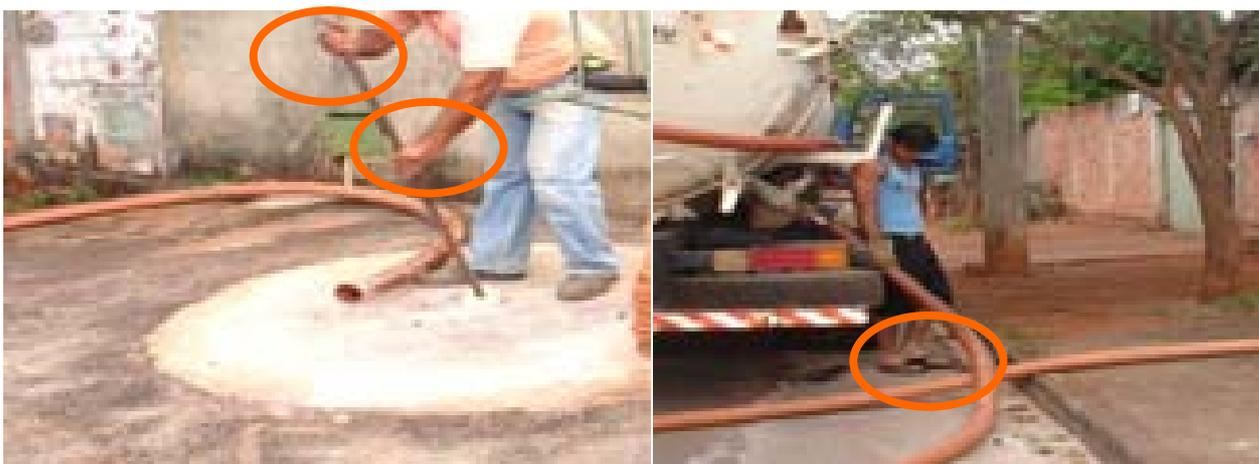
**Figura 23 – Exemplos de uso precário de equipamentos de proteção individual durante a operação de esvaziamento de sistema individual de tratamento de esgoto**
