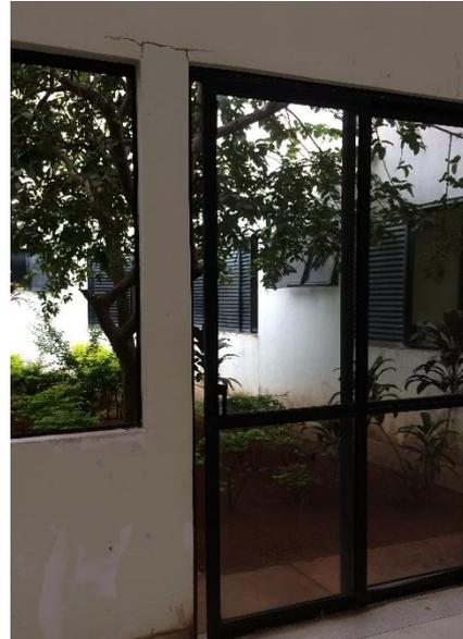
Figura 44: Rachaduras e infiltrações. Fonte: Arquivo da Autora, 2018.
