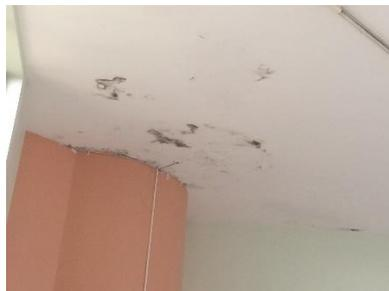
Figura 53: Infiltrações no teto da recepção da maternidade. Fonte: Arquivo da autora, 2017.
