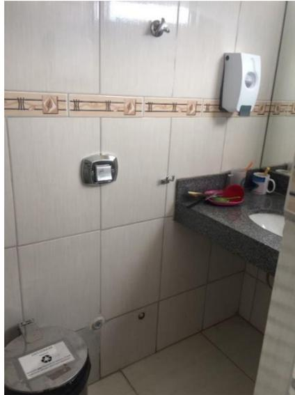
Figura 46: Sanitário transformado em copa, sem a retirada dos elementos sanitários. Fonte: Arquivo da autora, 2017.
