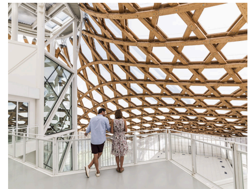
Figura 75 - elevadores e cobertura. Fonte: Archdaily.
