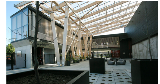
Figura 59 - Cobertura em MLC. Fonte: Arauco.
