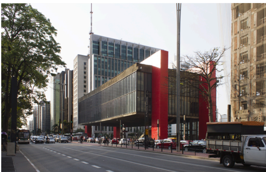
Figura 81 - Fachada MASP fonte: Archdaily.
