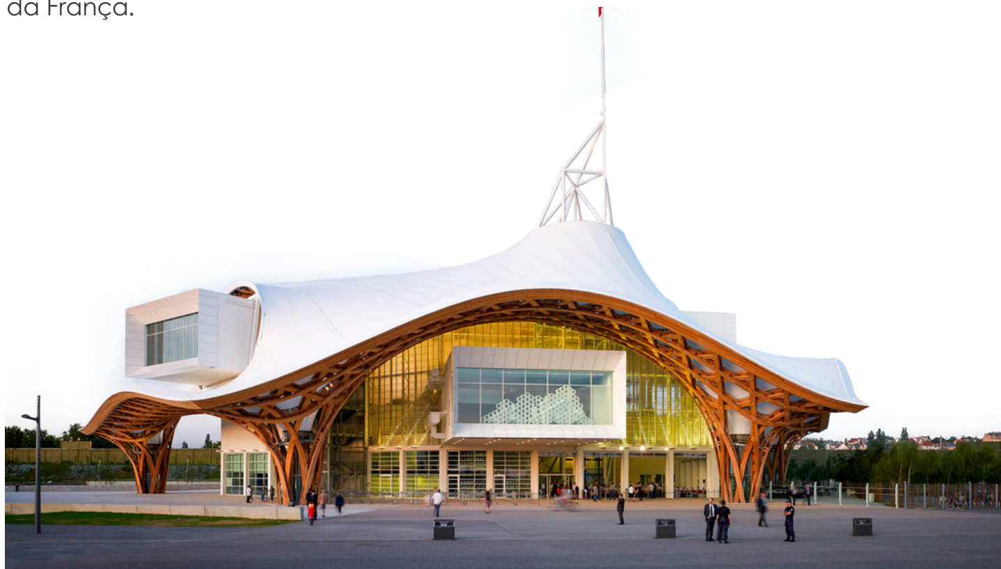
Figura 67 - Fachada Pompidou. Fonte: Jean de Gastines.
