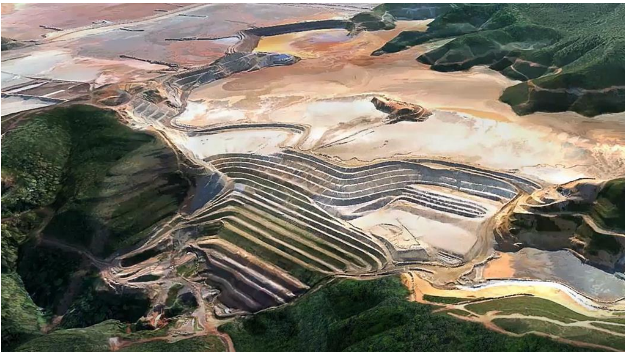
FIGURA 1: Visão geral da Barragem de Fundão (novembro de 2015).
