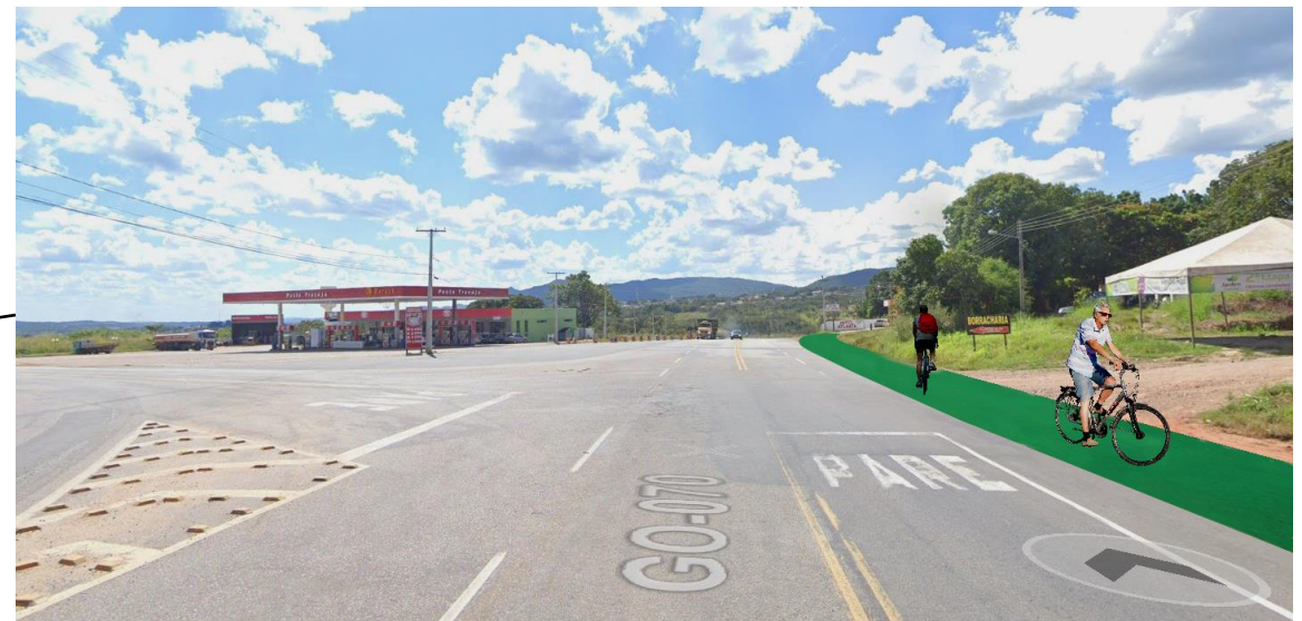
Imagem 55- Trecho ciclovia suspensa Fonte: Arquivo pessoal
