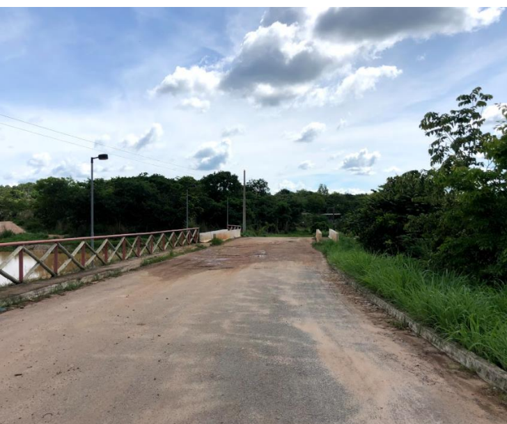
Imagem 33- Acesso pedestres e veículos (Rua GO-070) Fonte: Arquivo pessoal
