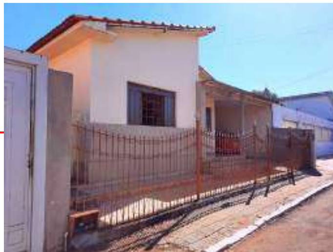
Figura 142 - Edificação nº 25. Uso residencial (2021). Fotografia por SANTOS, V. A. (2021).
