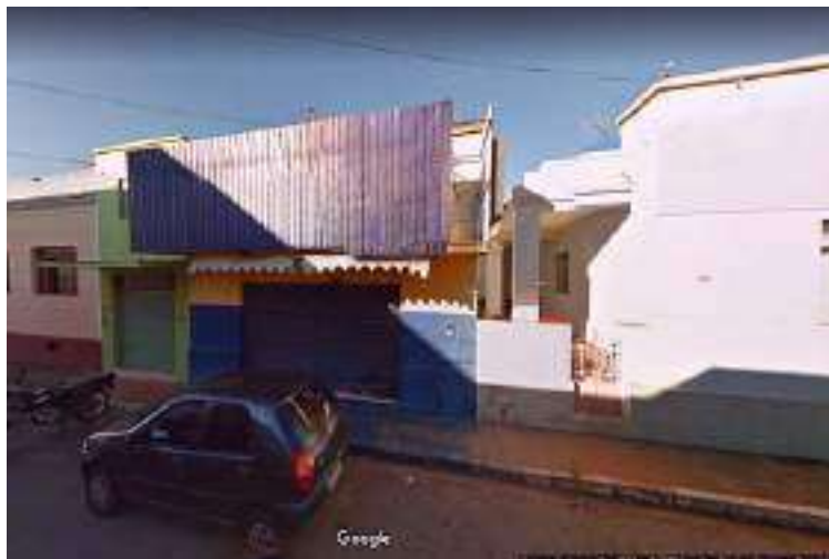
Figura 254 - Edificação nº 67. Uso comercial. Em inatividade (2012). Fonte: Google Maps, função Street View (2012); organizado por SANTOS, V. A. (2021).
