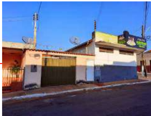
Figura 299 - Edificação nº 87. Uso residencial (2021). Fotografia por SANTOS, V. A. (2021).
