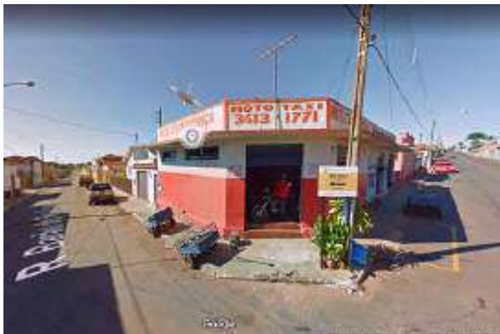
Figura 294 - Edificação nº 85. Uso comercial. Moto táxi (2012). Fonte: Google Maps, função Street View (2012); organizado por SANTOS, V. A. (2021).
