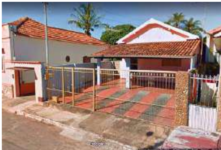
Figura 310 - Edificação nº 93. Uso residencial (2012). Fonte: Google Maps, função Street View (2012); organizado por SANTOS, V. A. (2021).
