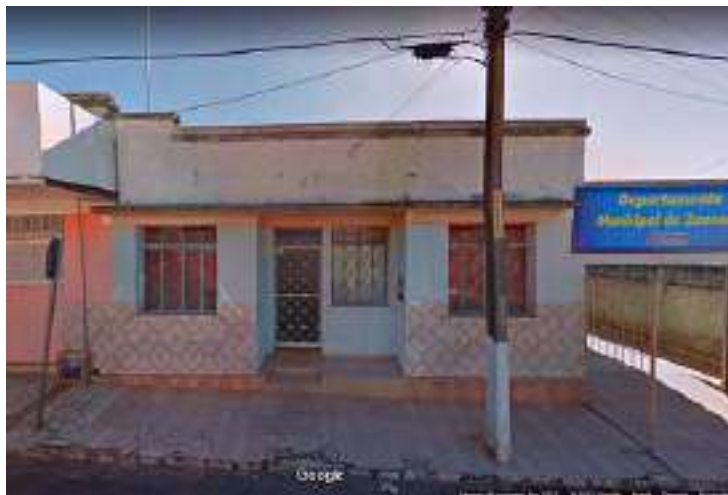
Figura 304 - Edificação nº 90. Uso institucional. Departamento Municipal de Zoonose (2012). Fonte: Google Maps, função Street View (2012); organizado por SANTOS, V. A. (2021).
