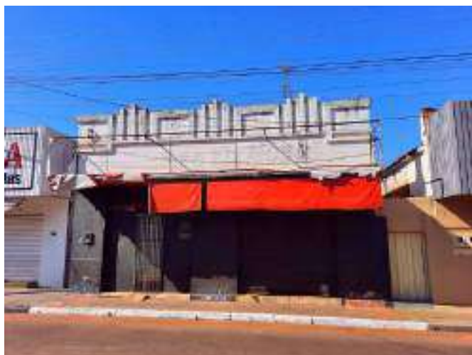
Figura 238 - Edificação nº 60. Uso comercial. Em inatividade (2021). Fotografia por SANTOS, V. A. (2021).
