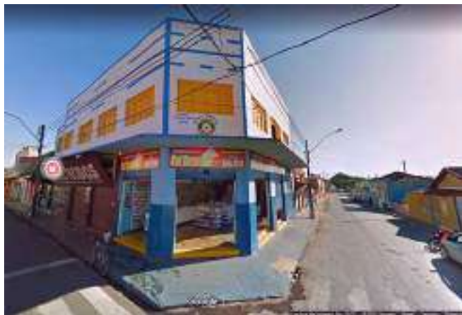
Figura 261 - Edificação nº 70. Uso comercial. Farmácia (2012). Fonte: Google Maps, função Street View (2012); organizado por SANTOS, V. A. (2021).
