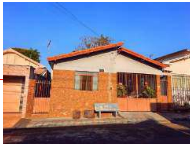
Figura 307 - Edificação nº 91. Uso residencial (2021). Fotografia por SANTOS, V. A. (2021).
