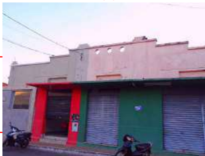
Figura 244 - Edificação nº 63. Uso comercial (2018). Fotografia por SANTOS, V. A. (2021).
