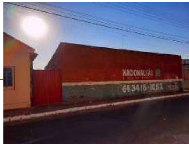
Figura 289 - Edificação nº 82. Uso comercial. Depósito de gás (2021). Fotografia por SANTOS, V. A. (2021).
