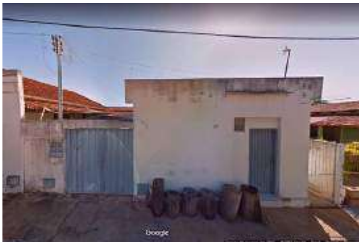
Figura 308 - Edificação nº 92. Uso residencial (2012). Fonte: Google Maps, função Street View (2012); organizado por SANTOS, V. A. (2021).
