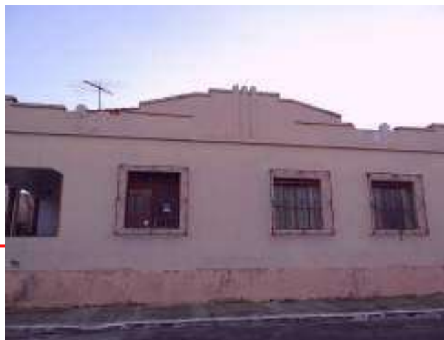
Figura 100 - Edificação nº 07. Uso residencial (2018). Fotografia por SANTOS, V. A. (2021).
