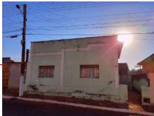
Figura 317 - Edificação nº 96. Uso residencial (2021). Fotografia por SANTOS, V. A. (2021).
