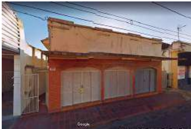
Figura 205 - Edificação nº 48. Uso comercial. Em inatividade (2012). Fonte: Google Maps, função Street View (2012); organizado por SANTOS, V. A. (2021).
