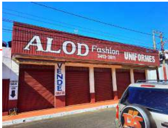
Figura 222 - Edificação nº 54. Uso comercial. Em inatividade (2021). Fotografia por SANTOS, V. A. (2021).
