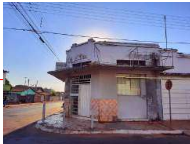
Figura 301 - Edificação nº 88. Uso comercial. Em inatividade (2021). Fotografia por SANTOS, V. A. (2021).
