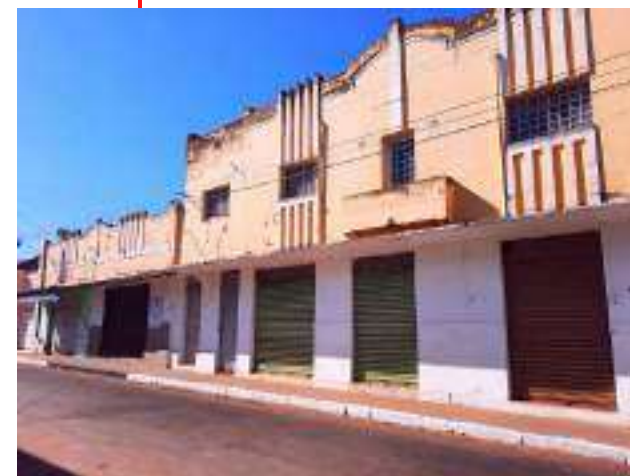
Figura 249 - Edificação nº 64. Uso comercial. Em inatividade (2021). Fotografia por SANTOS, V. A. (2021).
