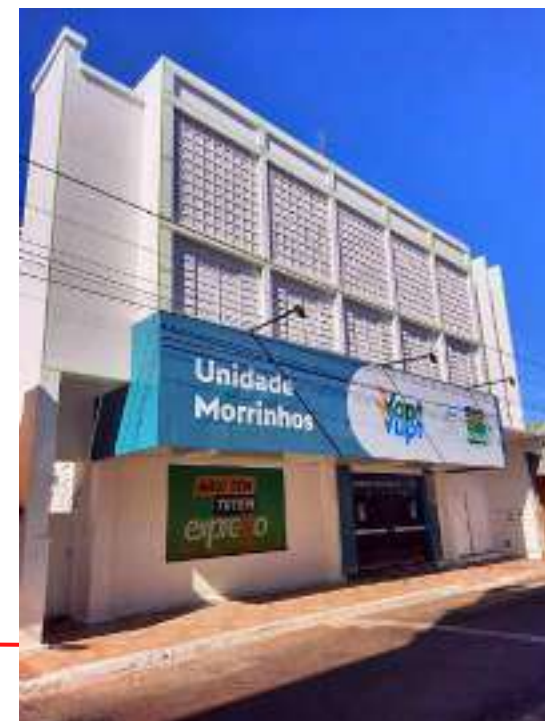
Figura 192 - Edificação nº 42. Uso institucional. Vapt Vupt (2021). Fotografia por SANTOS, V. A. (2021).
