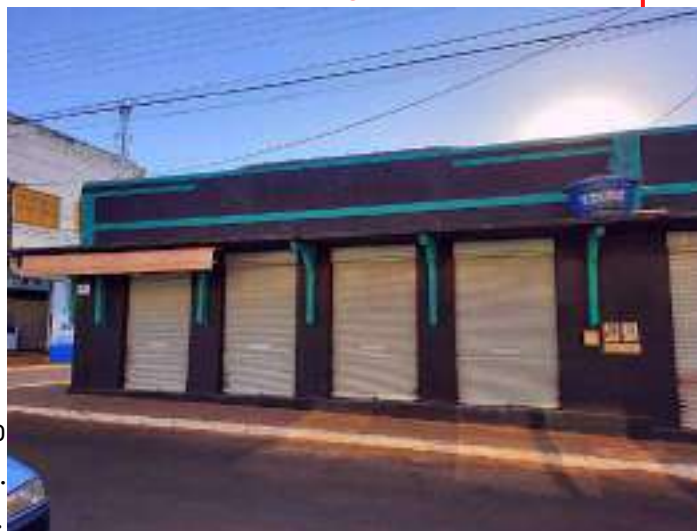
Figura 268 - Edificação nº 72. Uso comercial. Serviço de calhas (2021). Fotografia por SANTOS, V. A. (2021).
