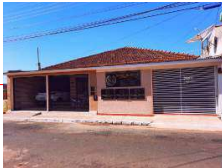
Figura 127 - Edificação nº 18. Uso misto. Residência e escritório de advocacia (2021). Fotografia por SANTOS, V. A. (2021).
