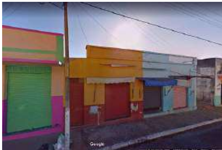
Figura 272 - Edificação nº 74. Uso comercial (2012). Fonte: Google Maps, função Street View (2012); organizado por SANTOS, V. A. (2021).
