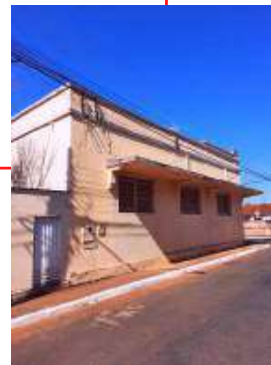
Figura 118 - Edificação nº 14. Uso comercial. Escritório de contabilidade (2021). Fotografia por SANTOS, V. A. (2021).
