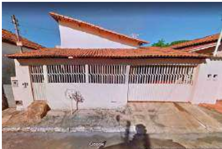
Figura 334 - Edificação nº 105. Uso residencial (2012). Fonte: Google Maps, função Street View (2012); organizado por SANTOS, V. A. (2021).
