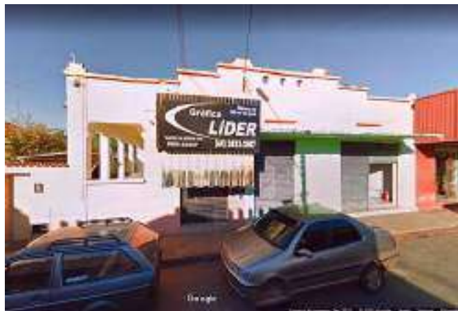
Figura 243 - Edificação nº 63. Uso comercial. Gráfica (2012). Fonte: Google Maps, função Street View (2012); organizado por SANTOS, V. A. (2021).
