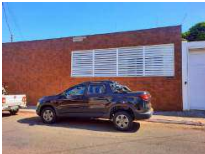
Figura 105 - Edificação nº 09. Uso residencial (2021). Fotografia por SANTOS, V. A. (2021).
