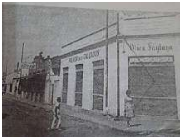
Figura 223 - Edificação nº 55. Uso comercial. Ótica e loja de calçados (1950). Fonte: BARBOSA (2016); organizado por SANTOS, V. A. (2021).
