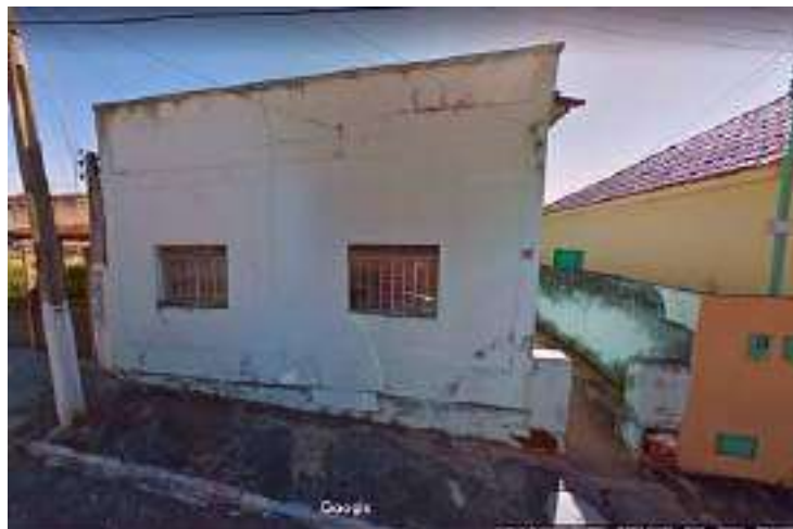
Figura 316 - Edificação nº 96. Uso residencial (2012). Fonte: Google Maps, função Street View (2012); organizado por SANTOS, V. A. (2021).
