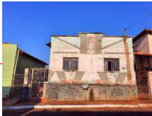
Figura 339 - Edificação nº 107. Uso residencial (2021). Fotografia por SANTOS, V. A. (2021).
