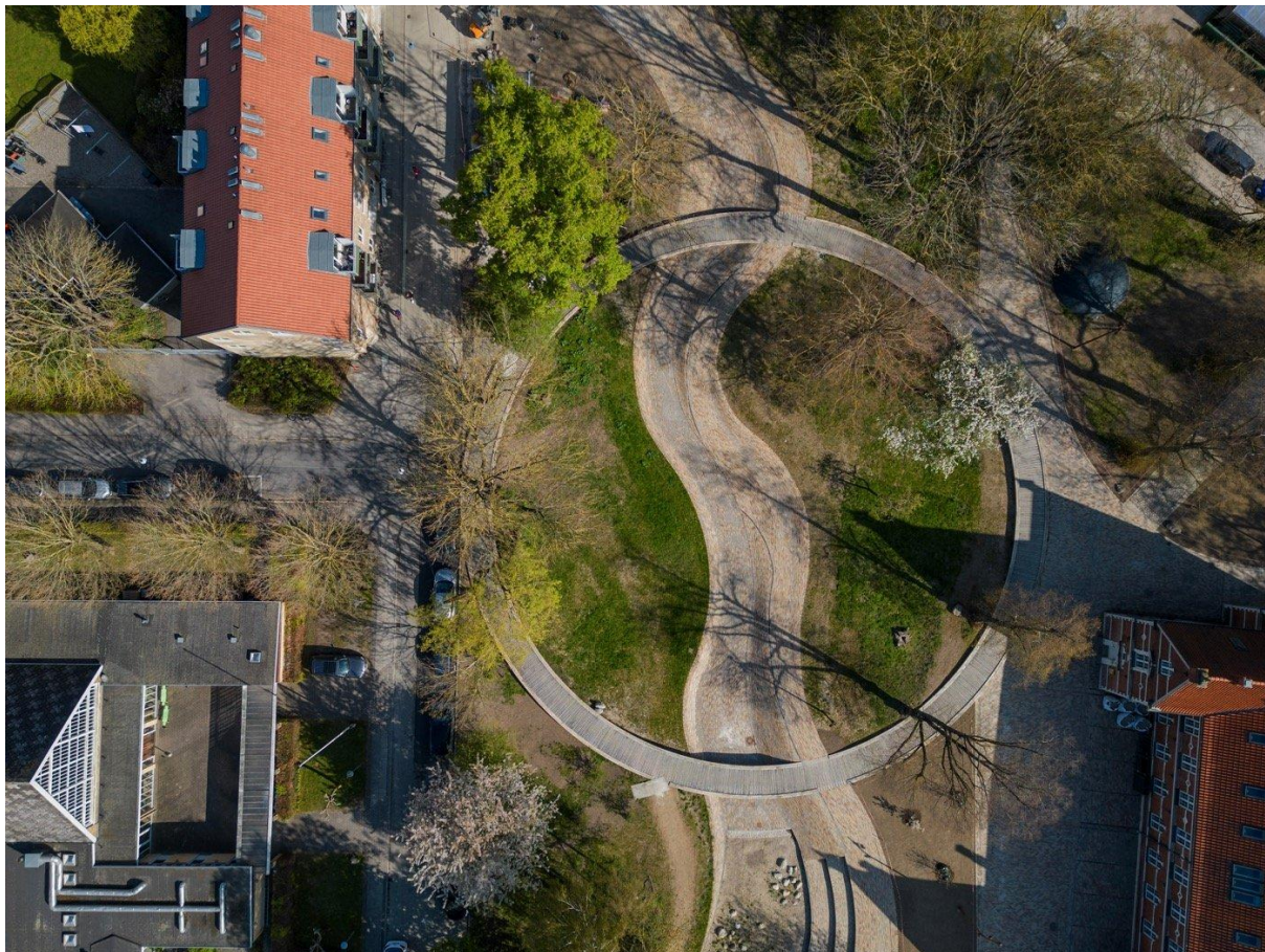
Figura 38 – Fotografia da ponte circular
