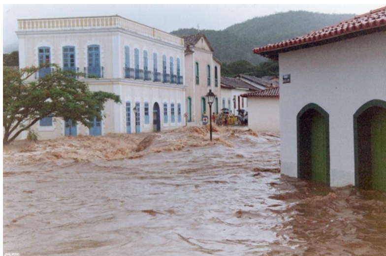
Figura 11 – Fotografia da Rua Hugo Ramos, na qual a água da enchente aparece encobrindo a Ponte do Carmo, ao fundo, o Hospital São Pedro de Alcântara
