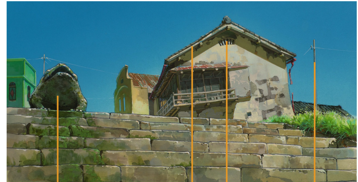
KIRIZUMA-ZUKURI (切妻造) 1 MUSHIKOMADO (虫籠窓) 2 FIAÇÃO ELÉTRICA 3 ESTÁTUA DE KAERU 4
