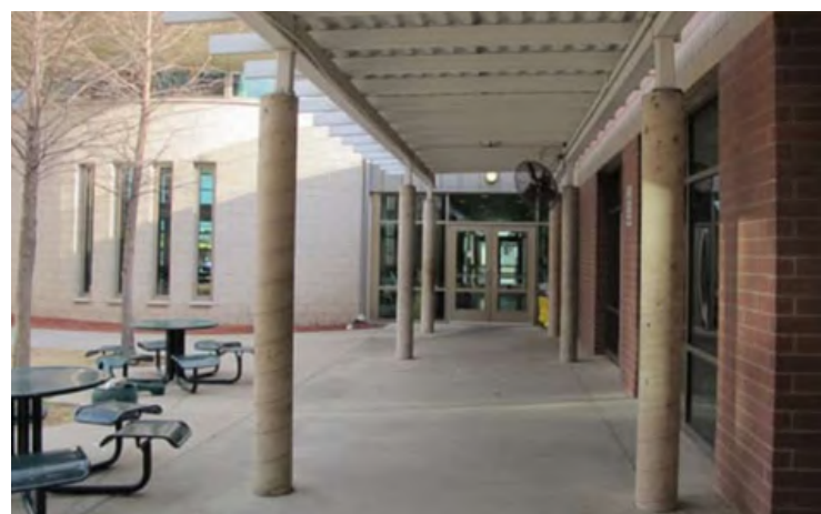
Figura 84: Corredor do centro de assistência. Fonte: Rudy Bruner Award.
