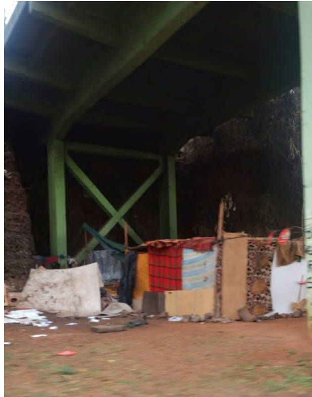
Figura 20: Ocupação embaixo do viaduto Clóvis Avelar Meneghetti em Franca - SP. Fonte: Elaborado pelo autor.
