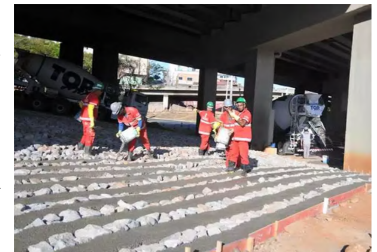
Figura 47: Instalação de pedras no viaduto em Belo Horizonte. Fonte: Estado de Minas Gerais.
