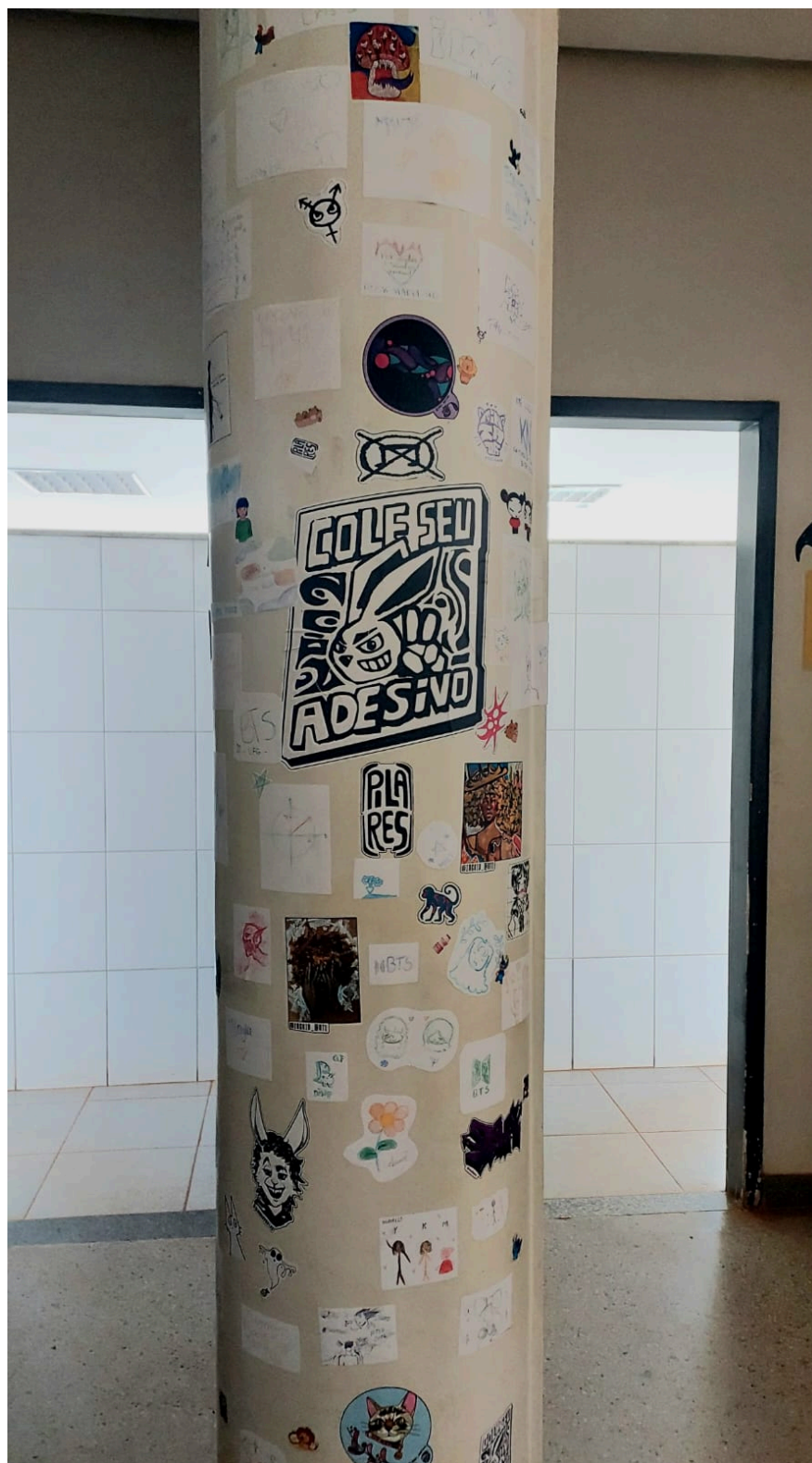
Figura 3 – Pilar de adesivos primeiro dia, andar térreo da FAV - UFG
