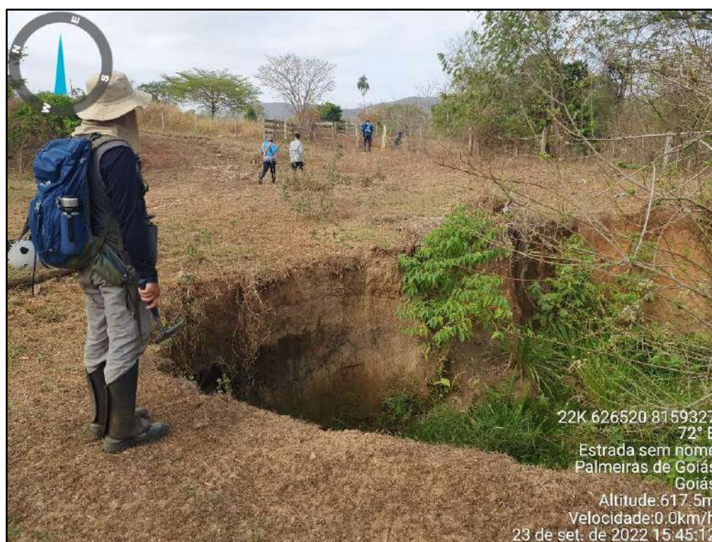
Figura 86: Formação de voçoroca nas margens do Córrego Mangueira.
