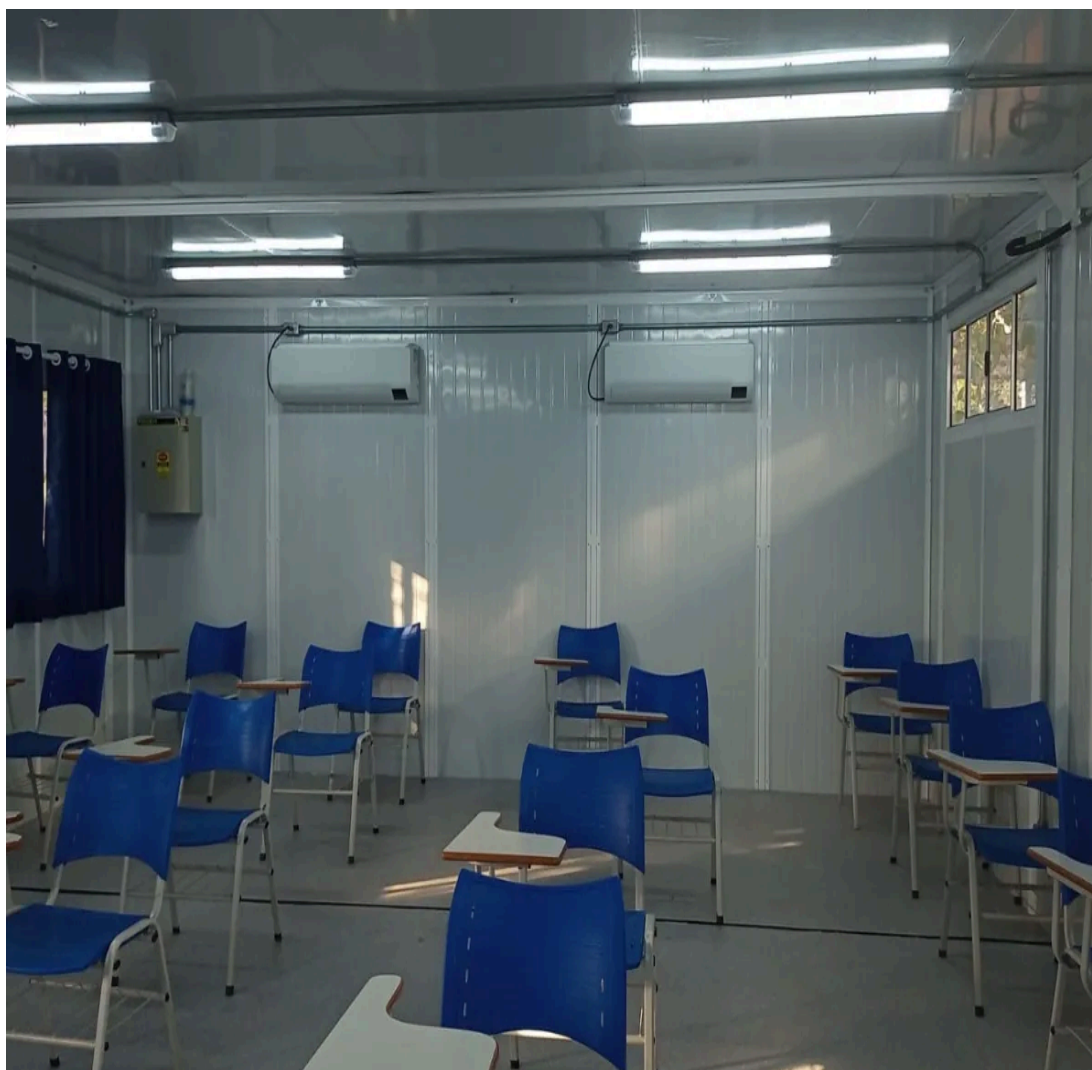
Imagem 2 — Escola contêiner em Goiânia.
