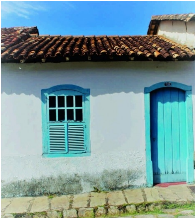
Tipologia edilícia encontrada na cidade de Goiás: porta e janela Foto Vinícius Antonelli de Souza, 2018
