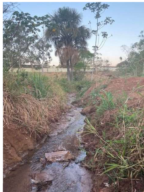
Figura 39: Veio d'água ao encontro do córrego São Bento.
