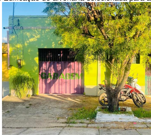
Figura 4. Edificação de alvenaria selecionada para a pesquisa.
