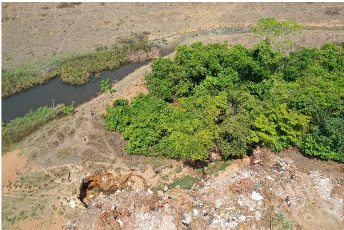
Figura 71: O voçorocamento progride em direção ao terreno descampado, pastagem.
