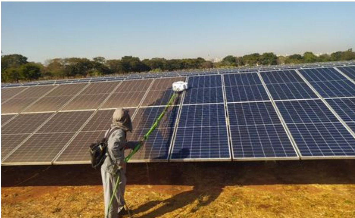
Figura 2 – Limpeza de painéis solares na Escola de Engenharia Mecânica da Universidade Federal de Goiás (UFG) – Campus Samambaia, junho/2024
