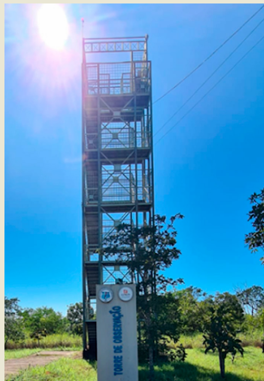
Figura 9 - Torre de Observação, Parque Estadual Telma Ortegal.
