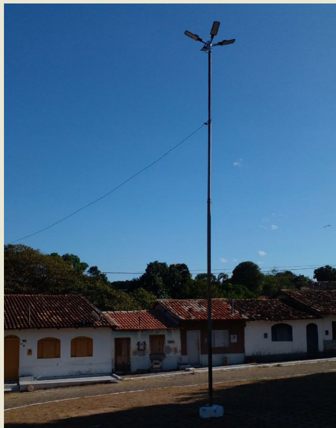
Figura 22 - Poste de iluminação centralizado
