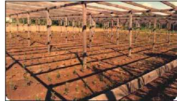
Imagem 39: Viveiro com Estrutura de madeiras e ripa
