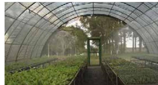
Imagem 42: Viveiro com estrutura metálica
