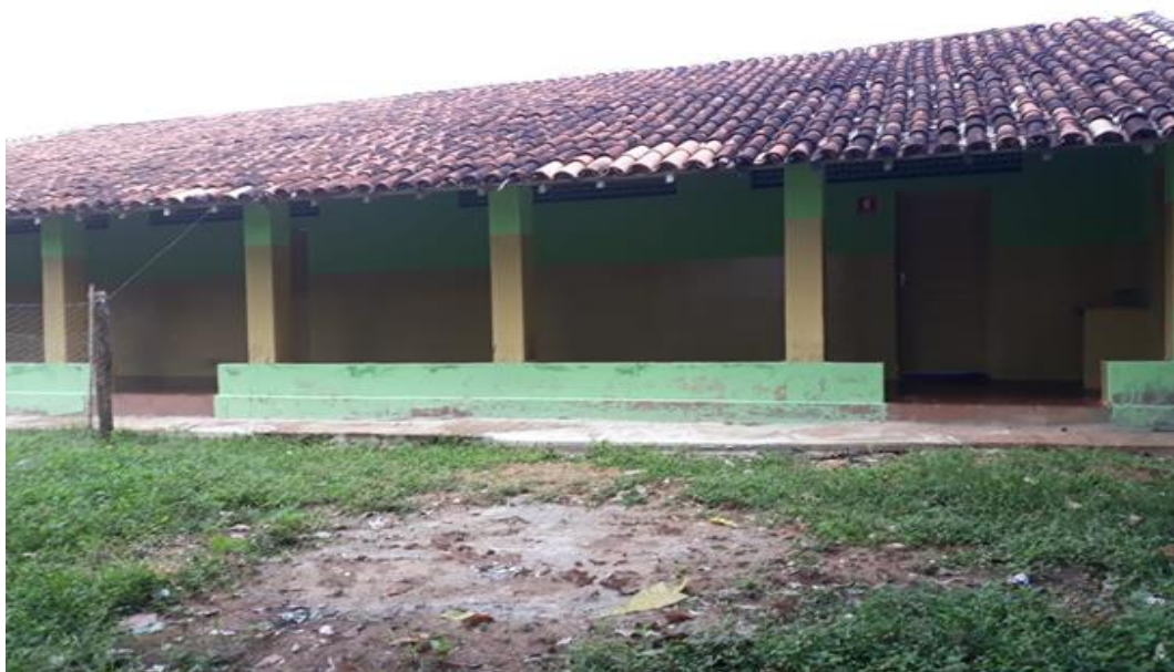
Figura 2- Prédio da antiga Escola Municipal de Buenolândia.
