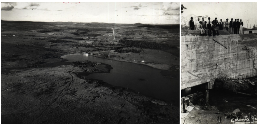
Figura 1: Jaó antes e durante a construção da usina
