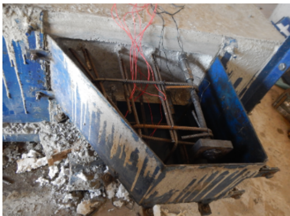
(b) Armadura do consolo pronta para concretagem
