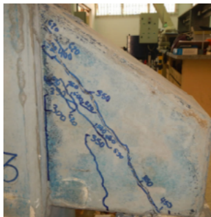
(b) Fundo do consolo A (P1)
