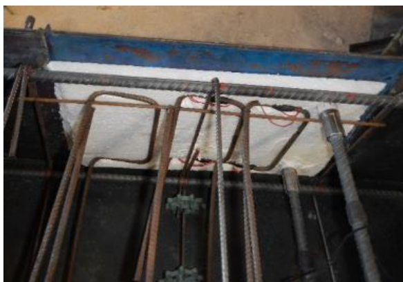
(a) Detalhe da armadura normal à interface antes da concretagem do pilar
