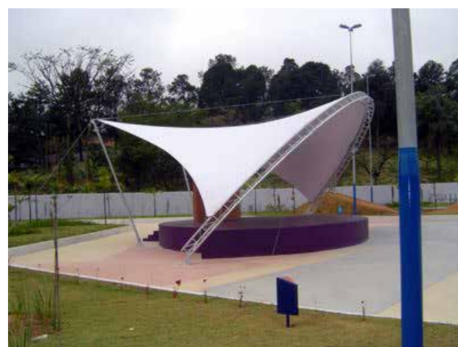
Membrana tensionada e concha acústica: recurso para sombreamento, orientação no espaço e criação de área para eventos, exposições e permanência.
