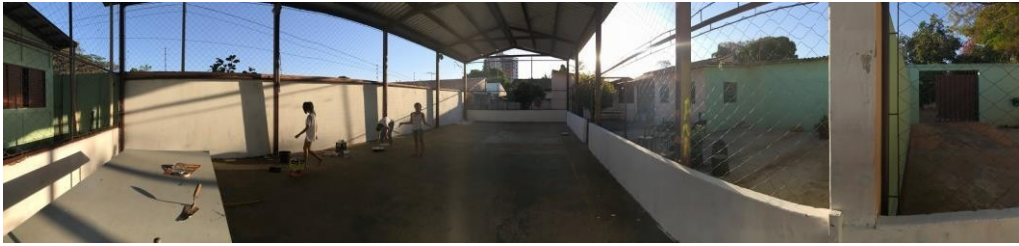
Figura 70 - Resultado final da cobertura
