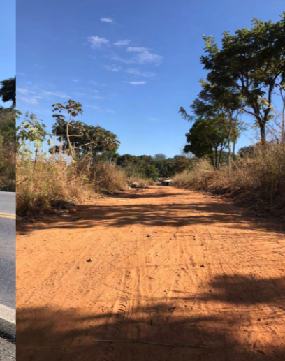
Figura 28- Via não - pavimentada
