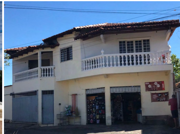
Figura 46 - Edificação mista de dois pavimentos
