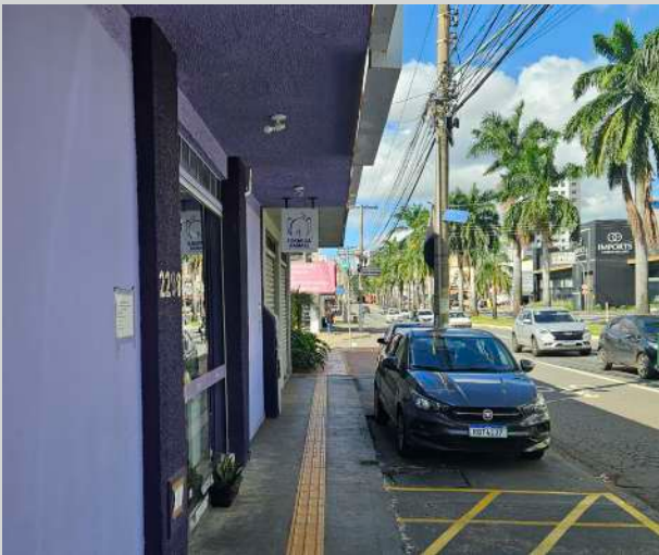
Figura 63: Calçadas com desníveis, irregularidades e estacionamentos.
