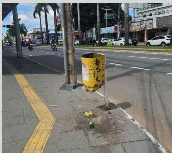
Figura 62: Lixeira em condição inadequada na T-63. Fonte: do autor, 2025.
