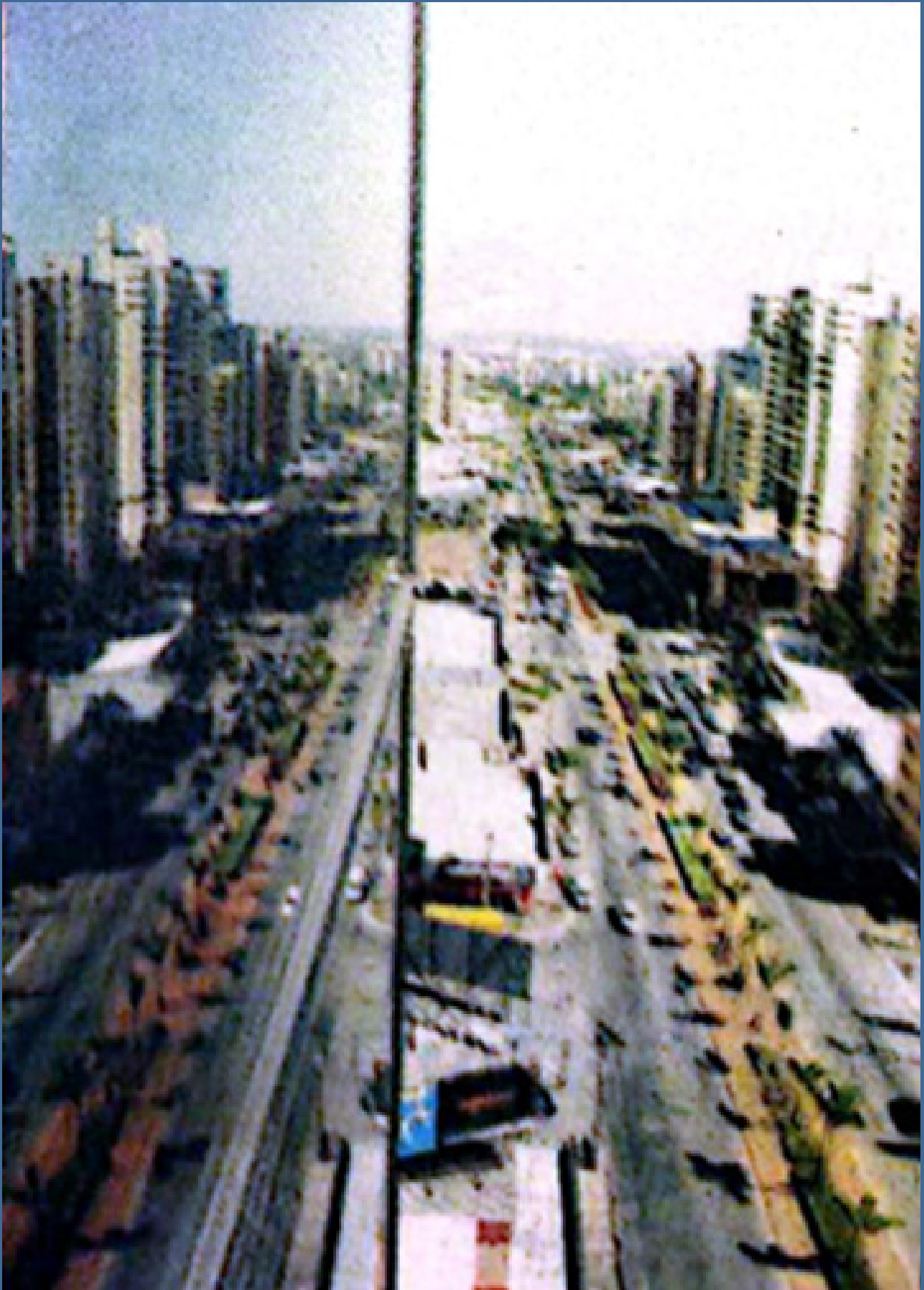
Figura 30: Situação do canteiro da T-63 em 2007. Fonte: Diário da Manhã, 2007.
