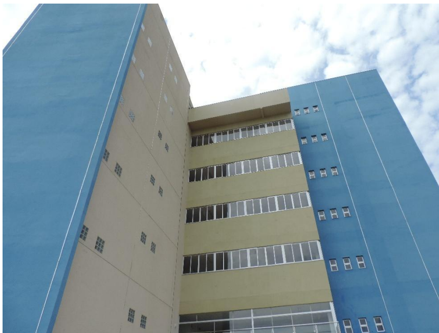
Figura 14: Fotografia das atuais instalações da FCT
