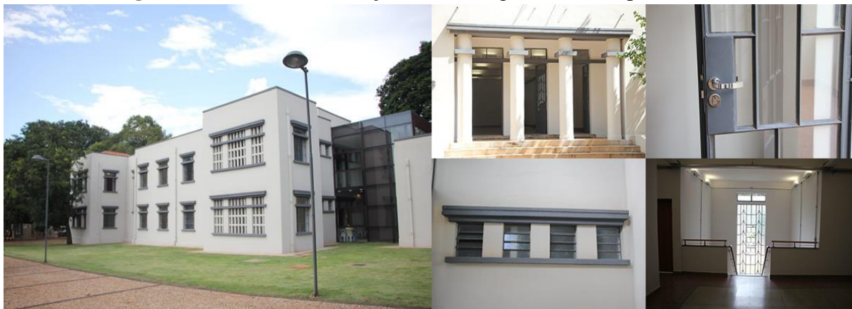
Figura 13 - Centro de Inovação e Tecnologia de Goiás após reformas.
