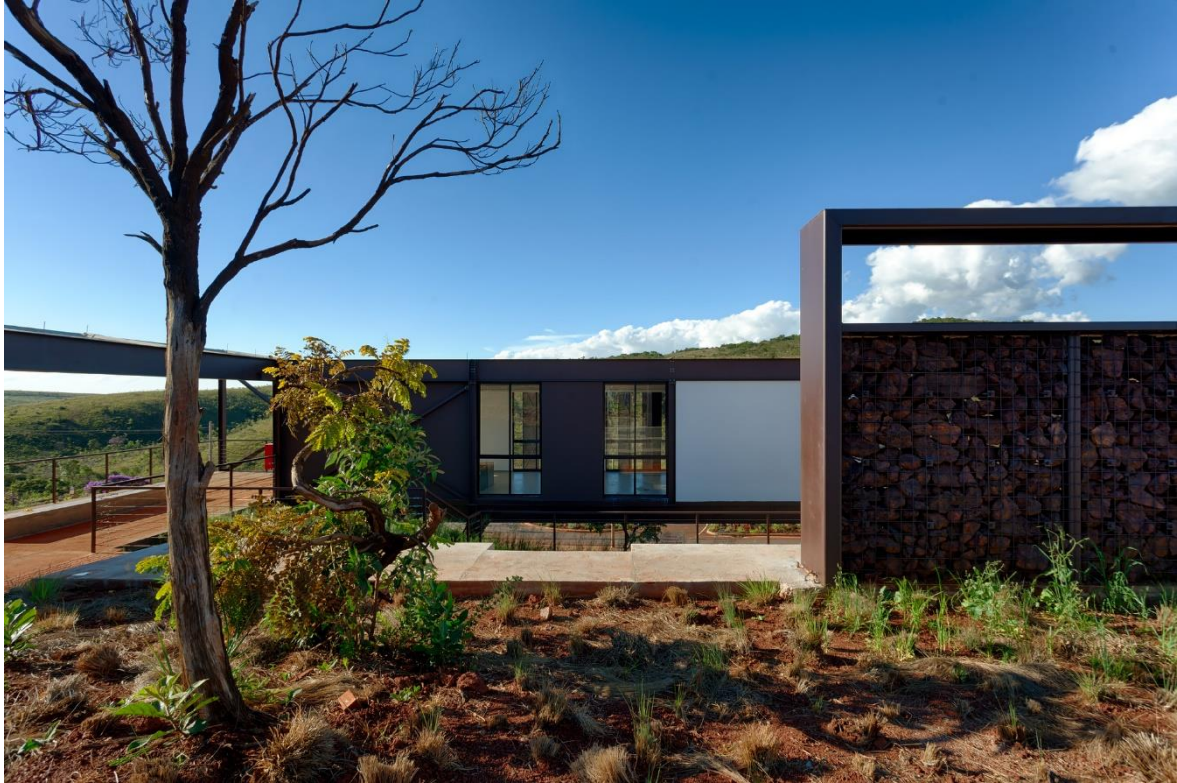
Figura 32: Materialidade da edificação.
