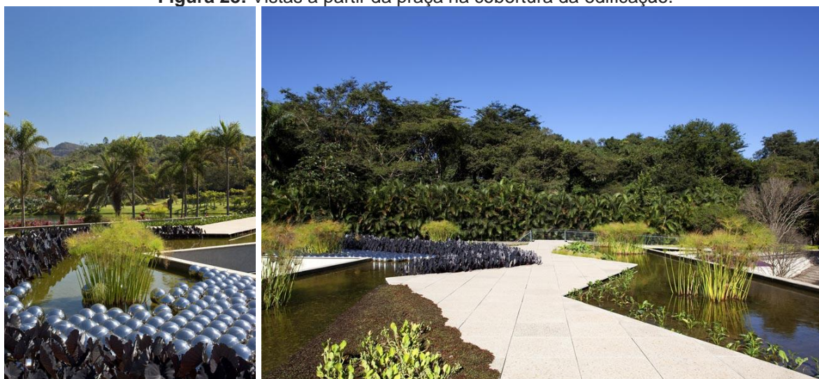
Figura 28: Vistas a partir da praça na cobertura da edificação.
