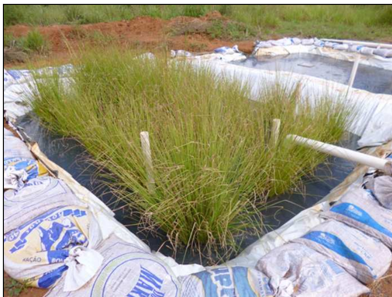
FIGURA 1 – Vista geral da estação experimental de tratamento de resíduos sépticos do tipo alagados construídos, com um leito vegetado e outro não.
