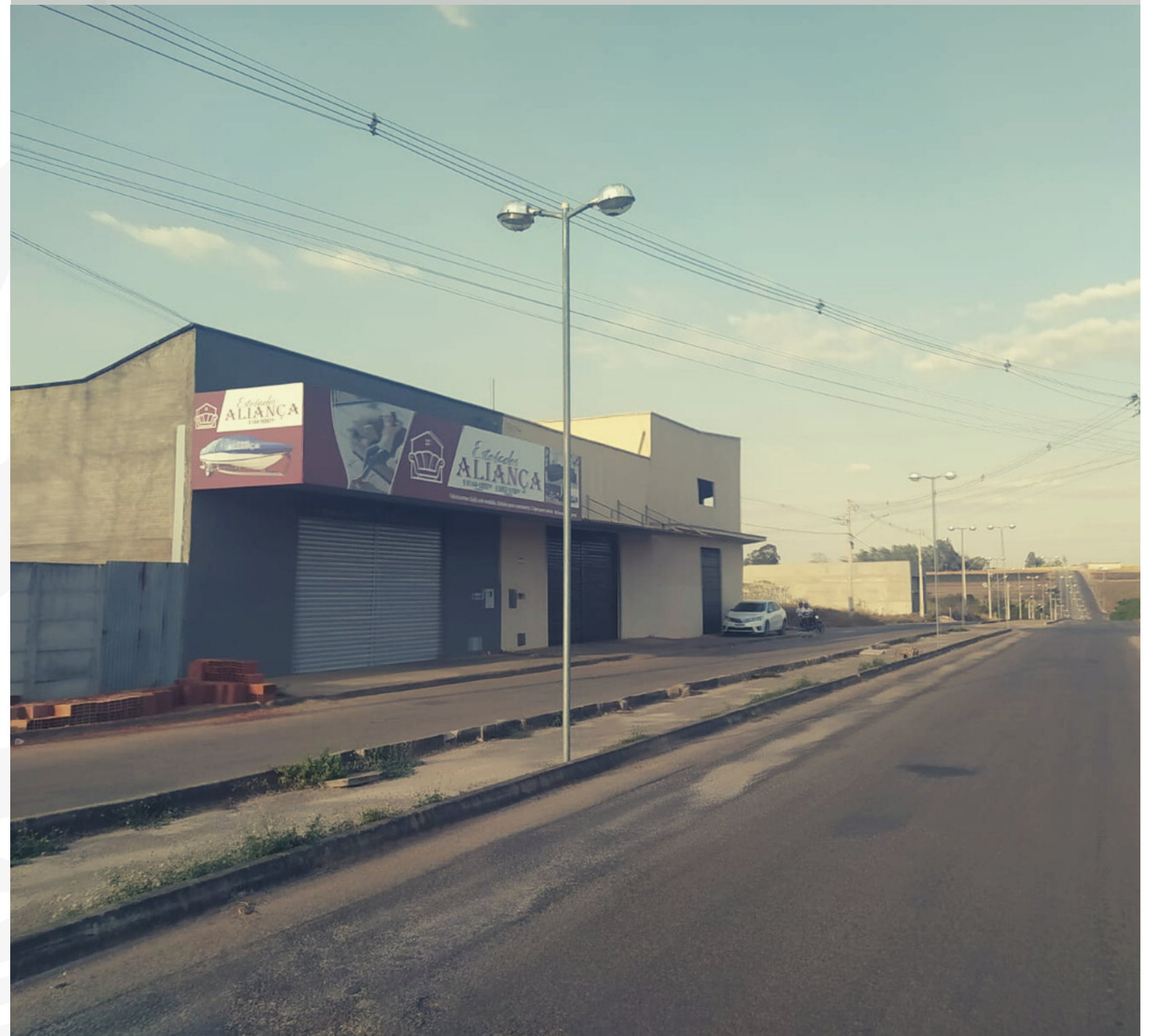
Figura 39: Construção de galpões comerciais na Av. Michelle Muniz. Fonte: Fotografia própria da autora.
