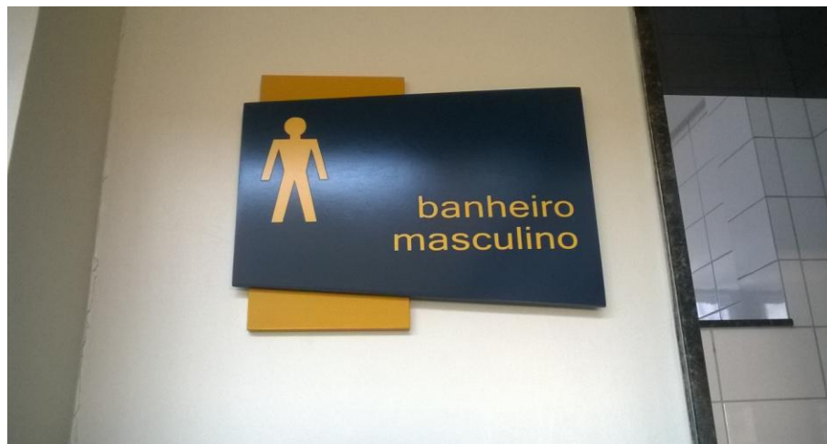
Figura 6: Banheiro sem identificação em Braille
